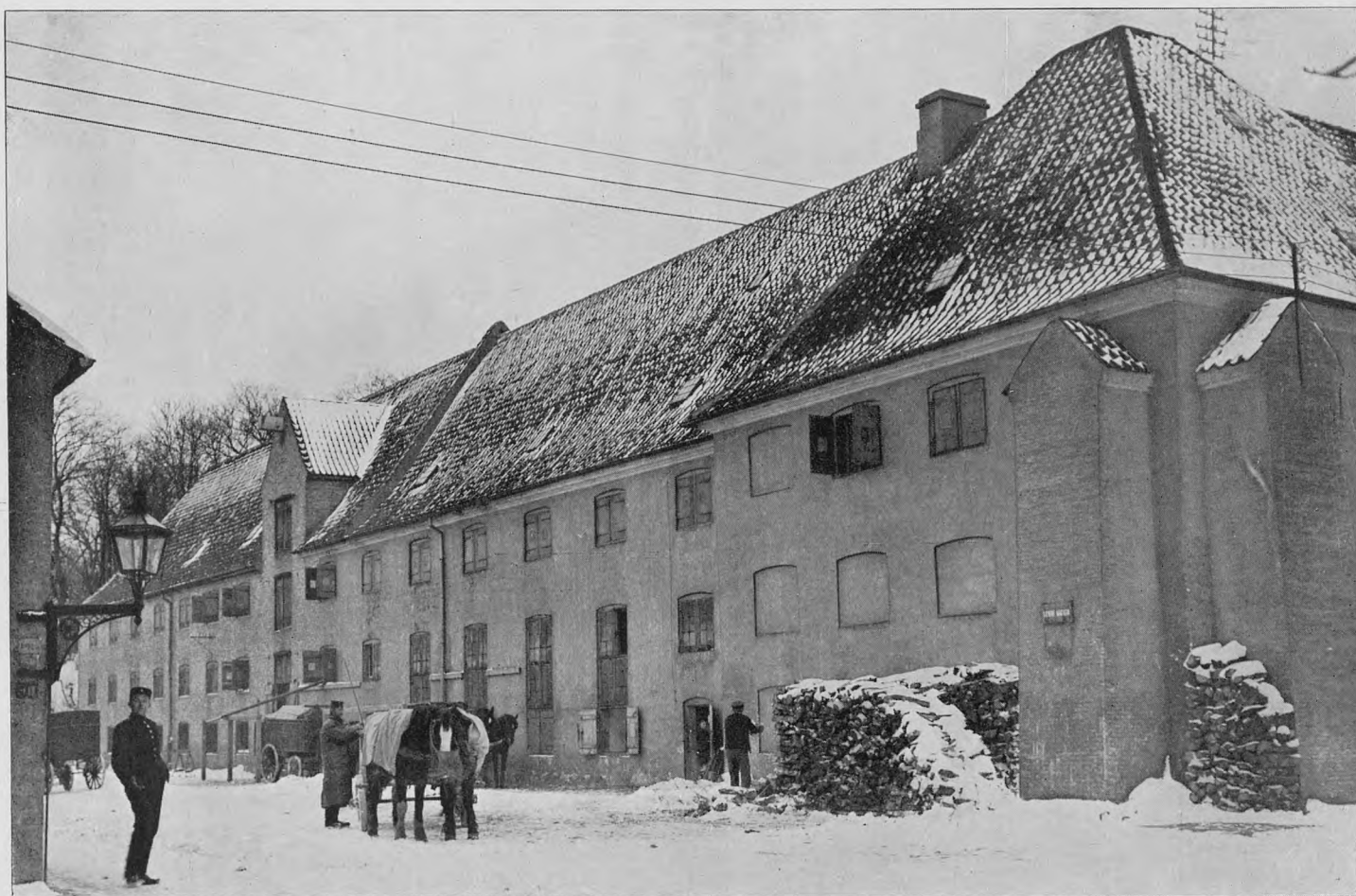
Søndre Magasinbygning, set fra Kirkepladsen; mærk de svære Stræbepiller paa det nordøstlige Hjørne.
