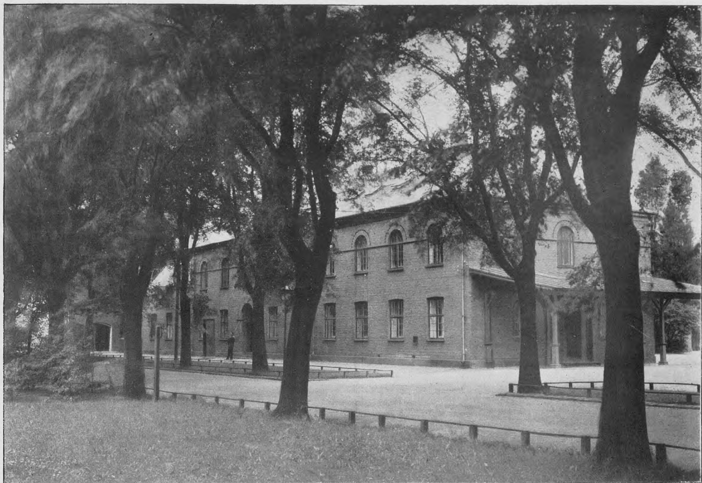
Kontorbygningen, set fra S. O., Aar 1900.
