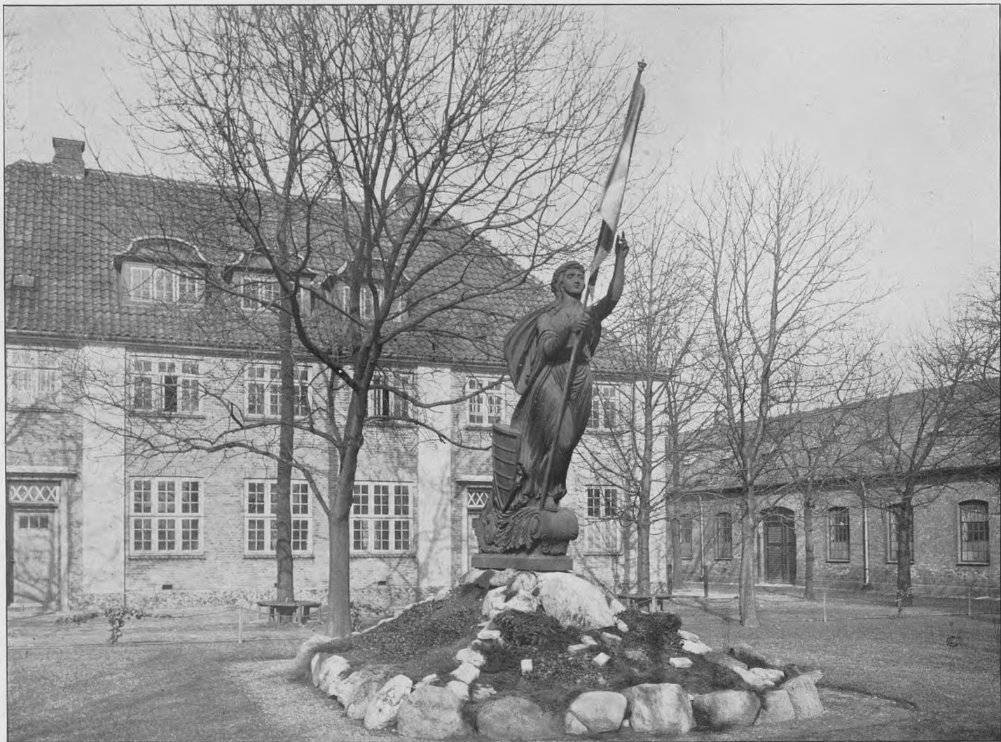
Fot. „Før og Nu“ ved Elfelt, 1924.
