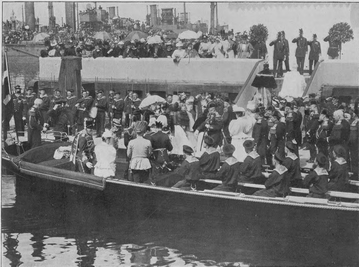
Kongefamilien gaar i Land paa Orlogsværftet fra den blaa russiske Kongechalup i Anledning af Panserbatteriet „Skjold“s Afløbning den 8. Maj 1896.
