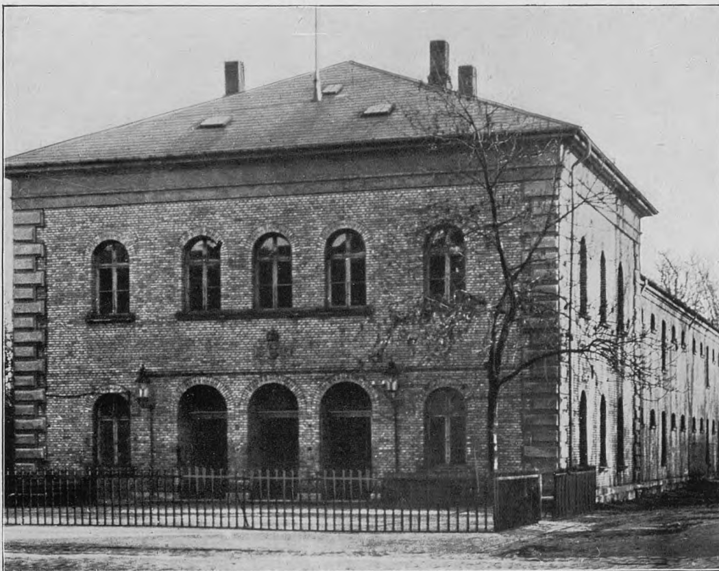
Hovedvagten, taget i Brug 1874, forlænget bagud i 1883.
