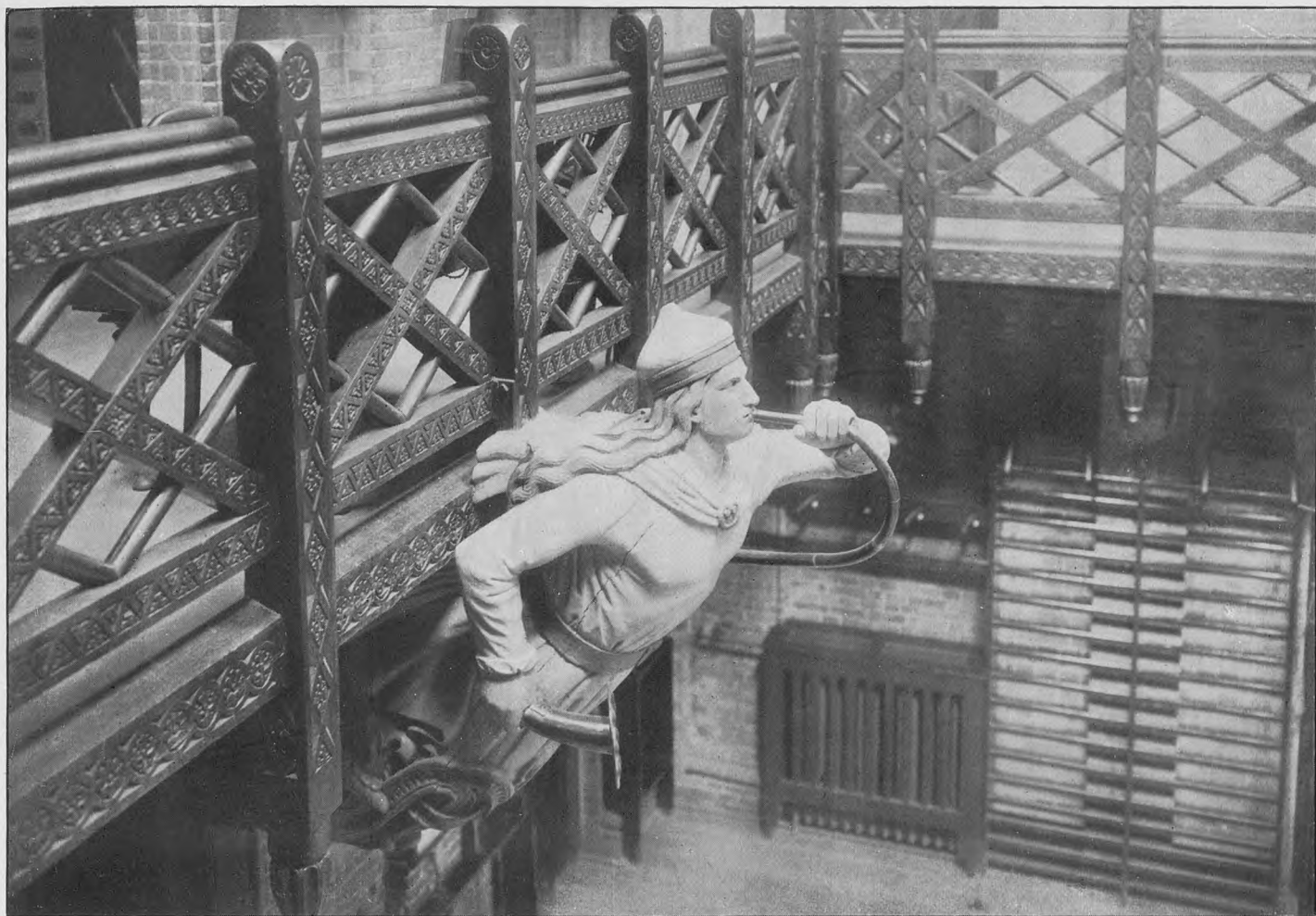
Fot. „Før og Nu“ ved Elfelt. 1924.
