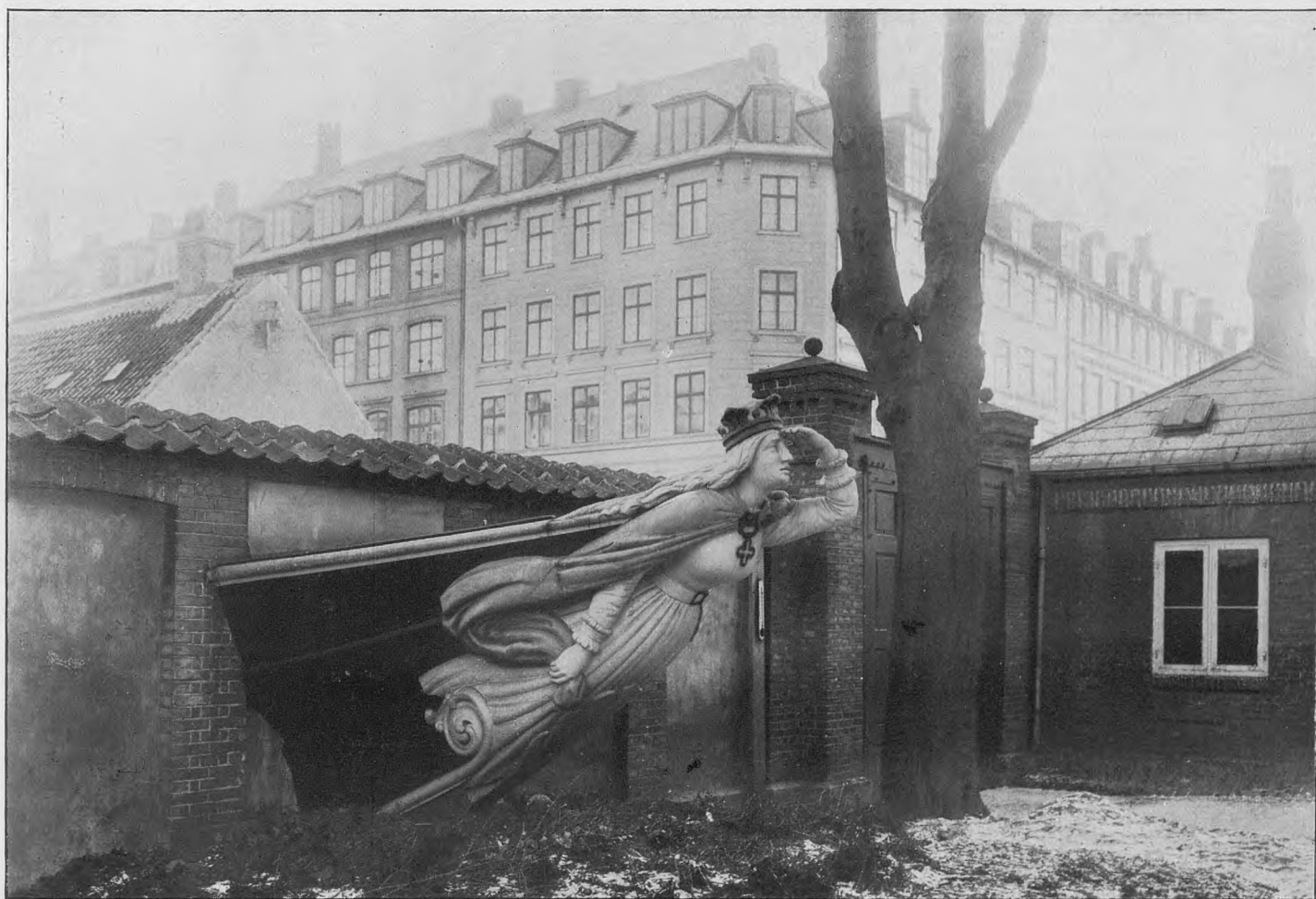
Fot. „Før og Nu“ ved Elfelt. 1924.
