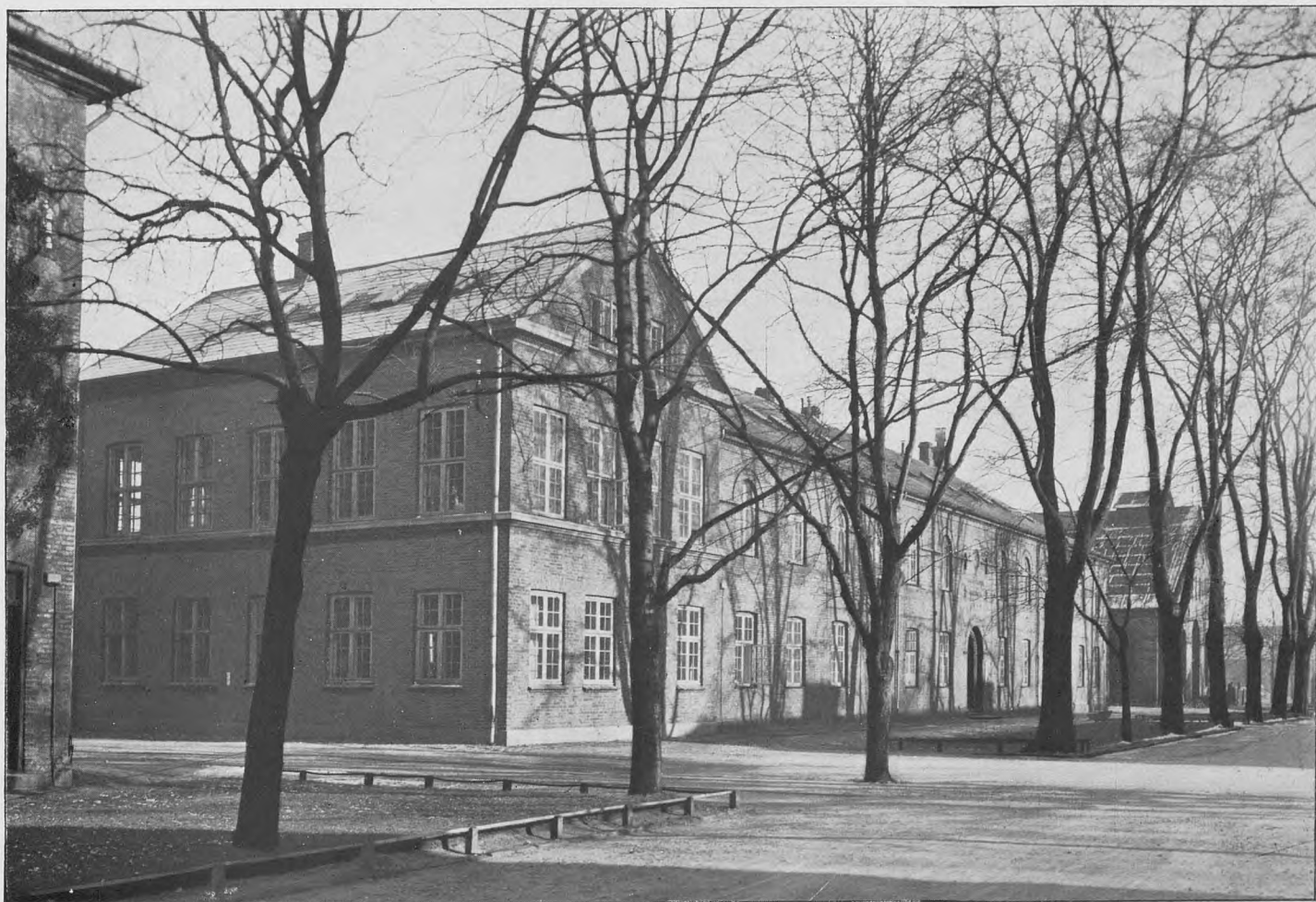
Fot. „Før og Nu“ ved Elfelt, 1924.
