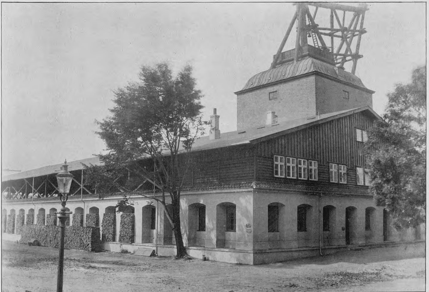
Nyholms Kran og Planbygning efter sidstnævntes Ombygning 1913.
