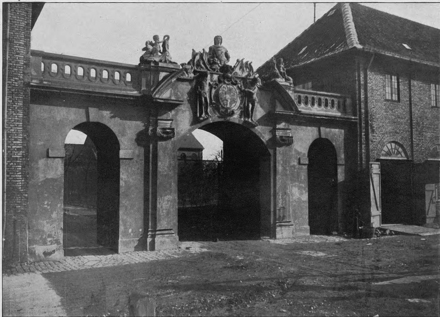
Porten i Arsenalbygningen.
