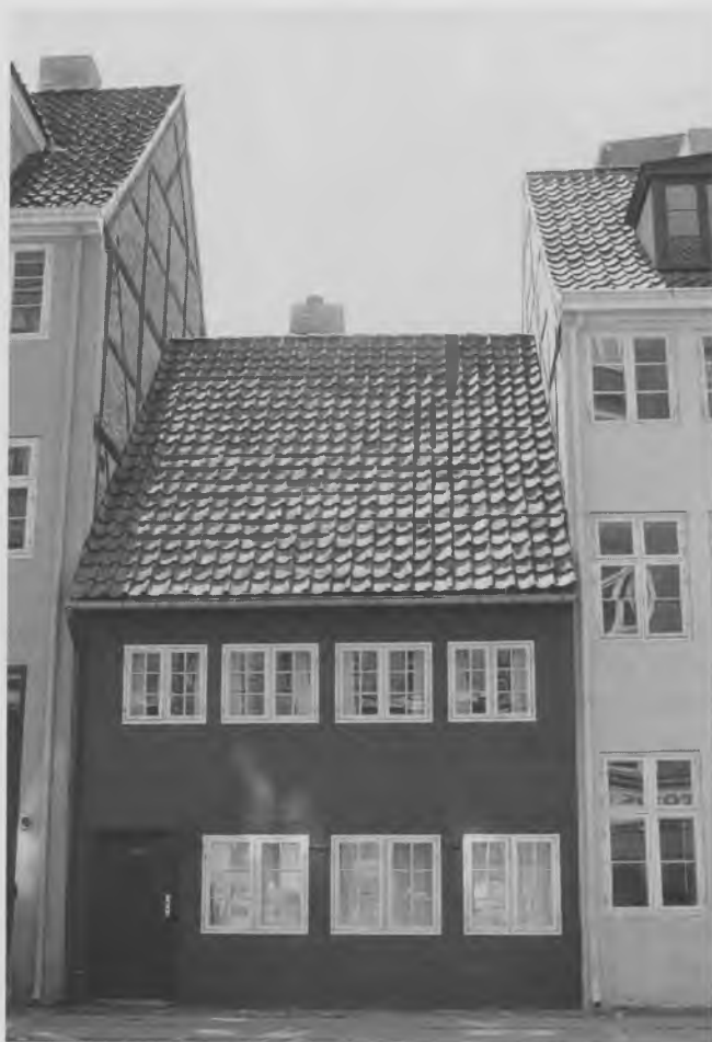
Fig. 7. Sankt Annægade 14, opført i 1630'erne, havde oprindelig kun beboelse i stueetagen, men allerede i begyndelsen af 1700-årene var overetagen også indrettet til beboelse. Her ses huset efter restaurering i 1978. Nationalmuseets Købstadundersøgelser.
