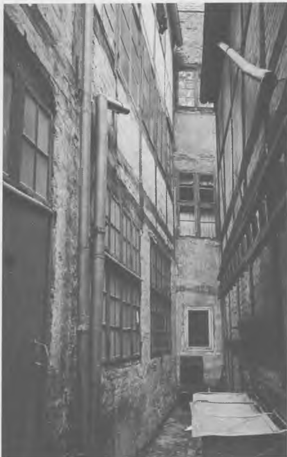
Slippen med den i teksten omtalte vandledning. Tv. mellembygningen til Admiral Gjeddes gård i St.Kannikestræde 10, th. baghuset til Krystalgade 5. Udateret foto i privateje.
