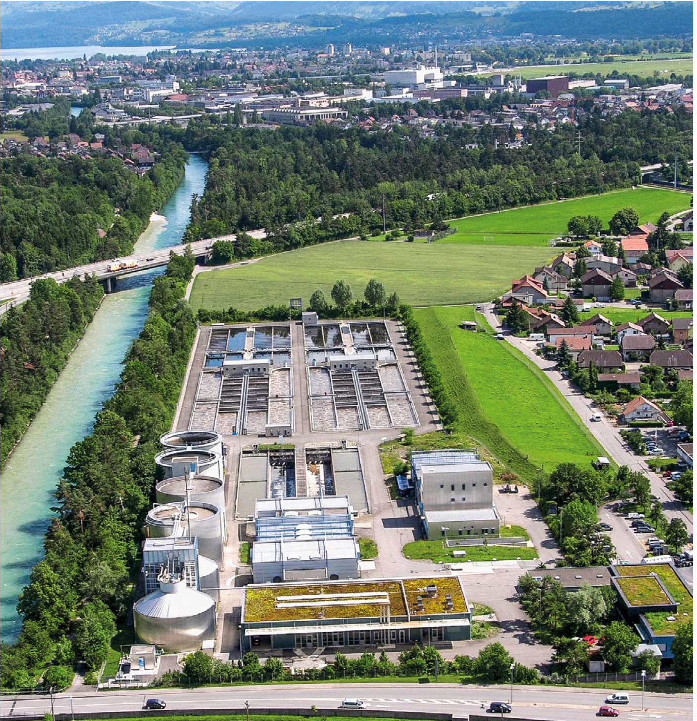
Ab Oktober soll die ARA Thunersee eine neue Anlage zur Gasaufbereitung in Betrieb nehmen.
