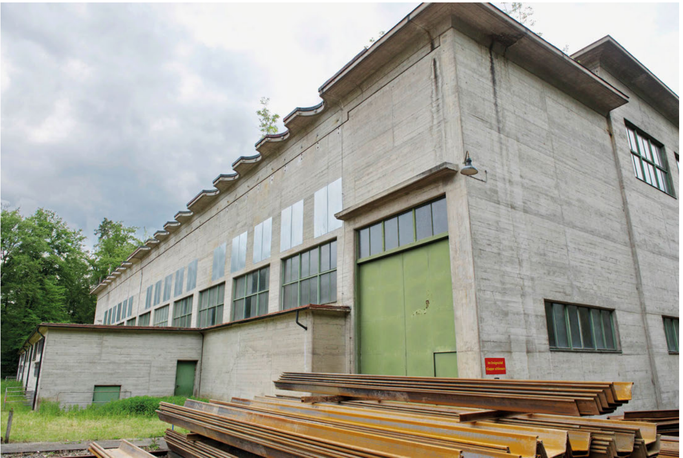
Aussenansicht des Biokraftwerks in Döttingen.
