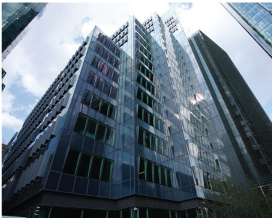
▲ Строительство элитного административного здания Ropemaker Place в Лондоне
