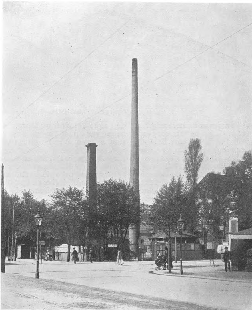
Den nye »dekorative« Skorsten paa Vandværket i Studiestræde.
