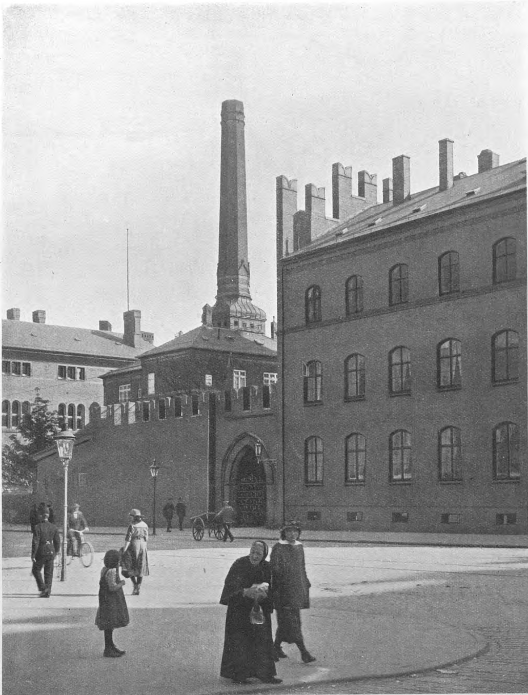
Skorsten paa Raadhusets Kedelbygning (Prof. M. Nyrop).
