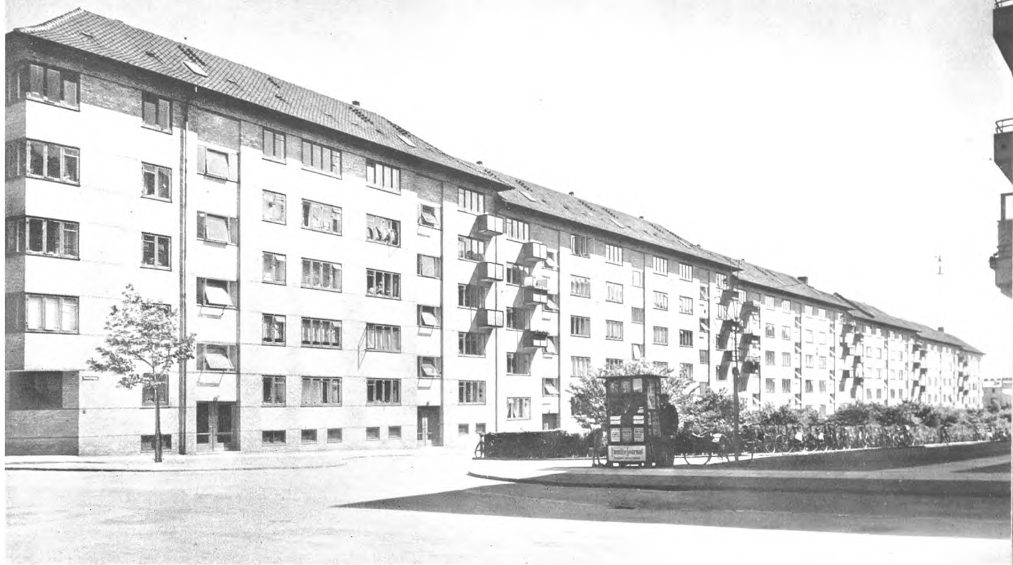
Skoleholdergaarden fra vest ud mod Præsteløngen, der paa midten er delt med en grøn indhegnet plæne. Der er kun ganske enkelte altaner til denne side. Til højre i forgrunden hjørnet af Degnegaarden.
