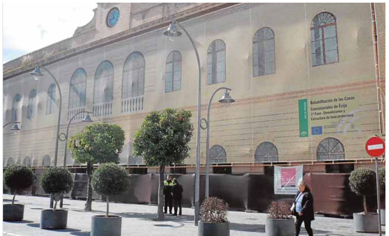
Tras la rehabilitación sólo se conservarán el salón de Plenos y la fachada neoclásica
