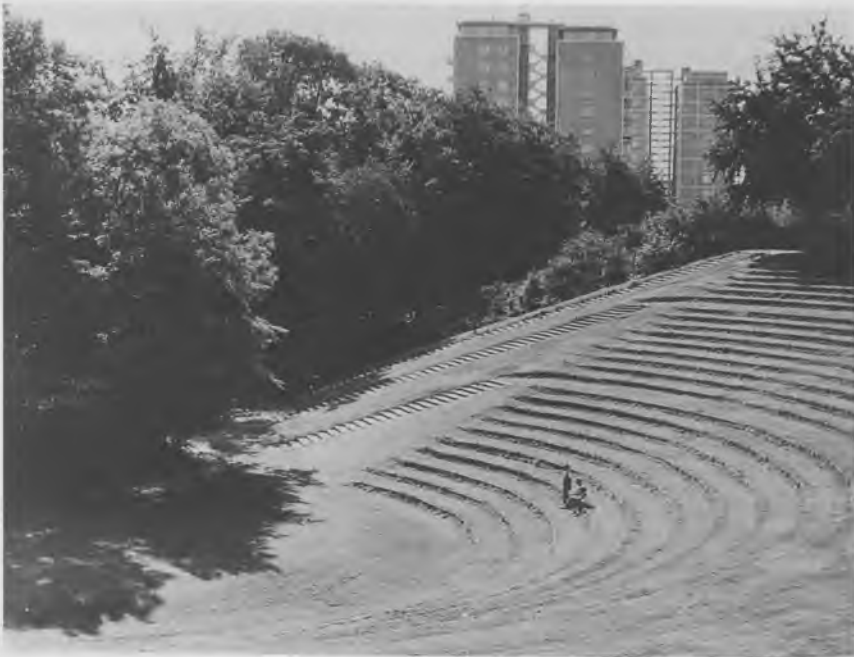
Bellahøj friluftsteater med punkthusene i baggrunden. Foto 1970, Københavns Bymuseum.
