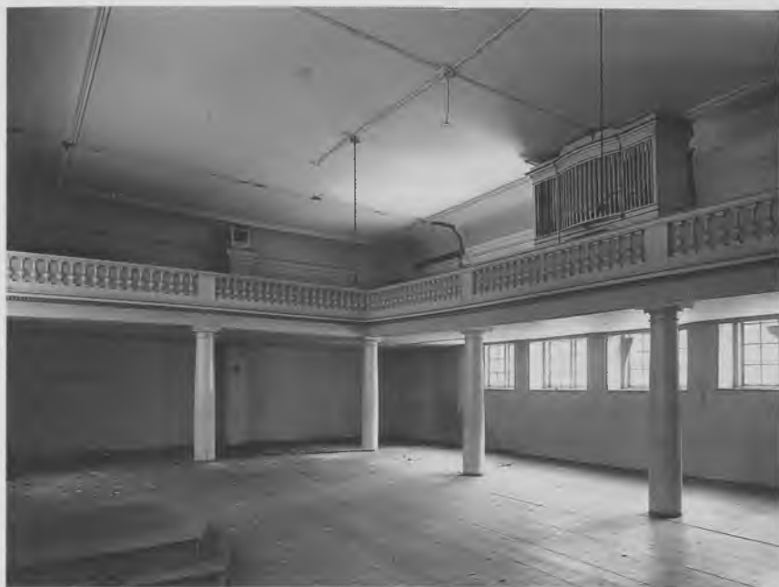
Brødremenighedens mødesal i Stormgade 21 før nedrivningen. Foto 1931. Nationalmuseet.
