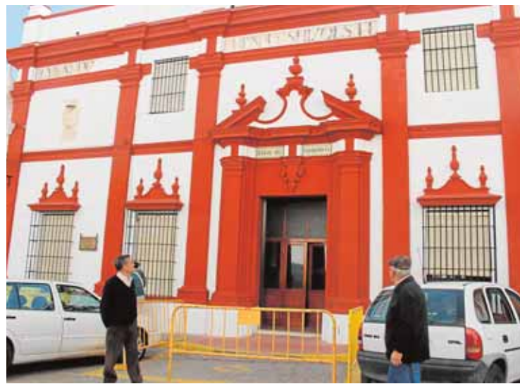
El Hogar del Pensionista, antiguo Pósito, luce reformado
