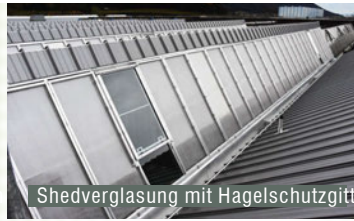
Sanierungen von Sheddächern
