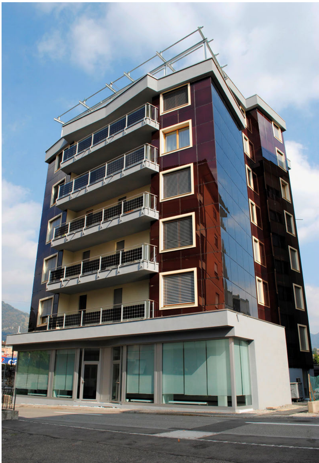
Vor der Sanierung waren nur 7 der 19 Wohnungen vermietet. Heute sind alle Wohneinheiten inklusive Laden und Garagen besetzt.
