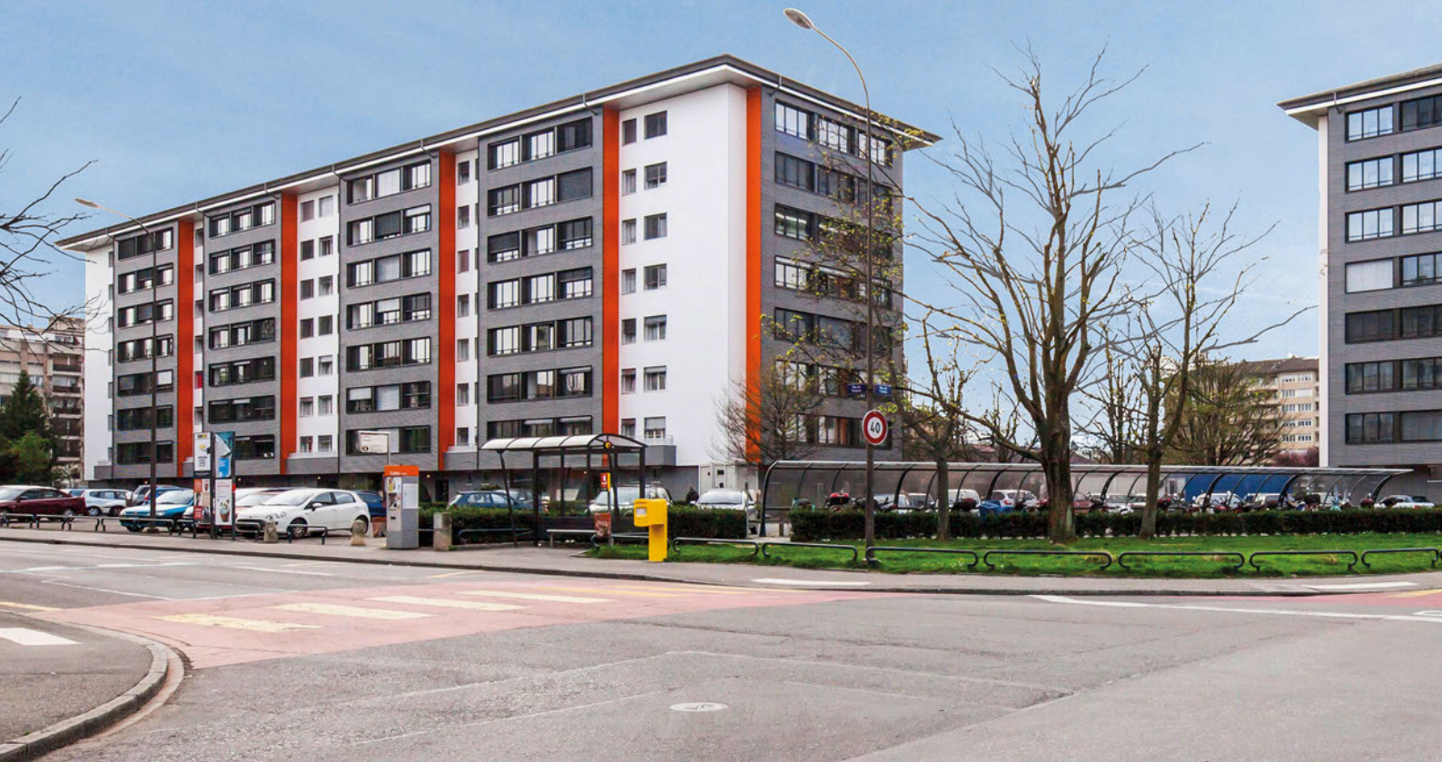
Le projet-pilote de la société coopérative La Cigale, à Genève, est la plus grande rénovation Minergie-P en Suisse. Elle a divisé par cinq les besoins énergétiques totaux des deux bâtiments des années 1950.
