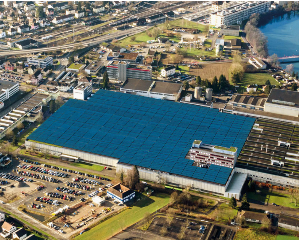
Die 50-jährige Fabrikhalle des Riverside-Areals in Zuchwil versorgt von ihrem Dach aus 1000 Einfamilienhäuser mit Elektrizität (Bild links). Auf dem Dach der Migros-Verteilbetriebs Neuendorf AG wird Strom für 1900 Haushalte produziert (Bild rechts). Bilder: zvg
