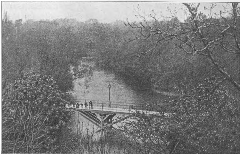
BROEN OVER STADSGRAVEN BAGVED TEGLGAARDSSTRÆDE
