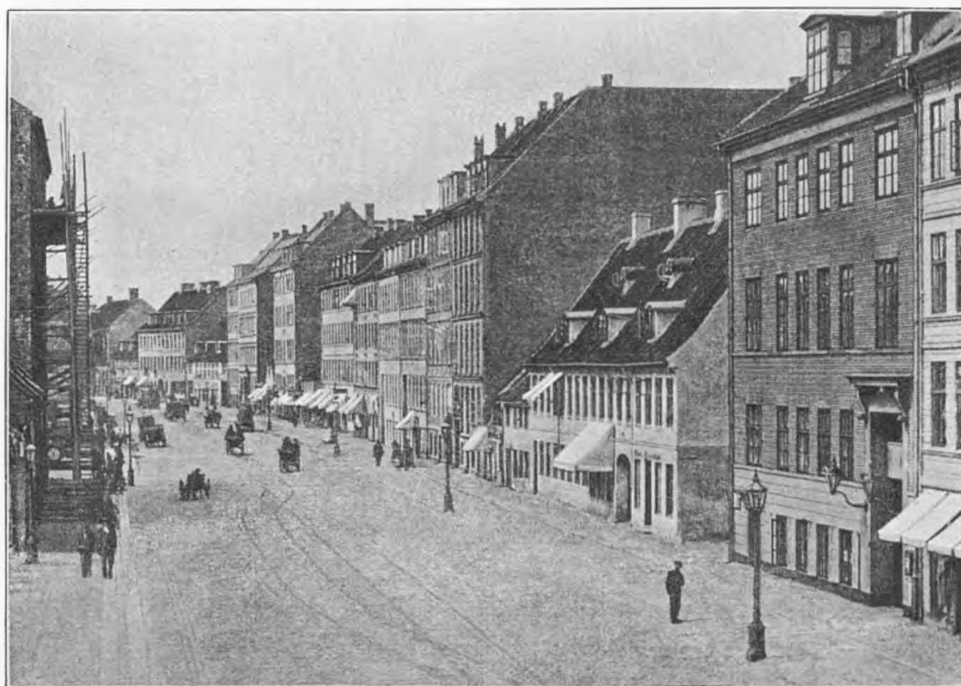
VESTERBROGADE MED NR. 48, HJØRNEHUSET TILHØJRE
