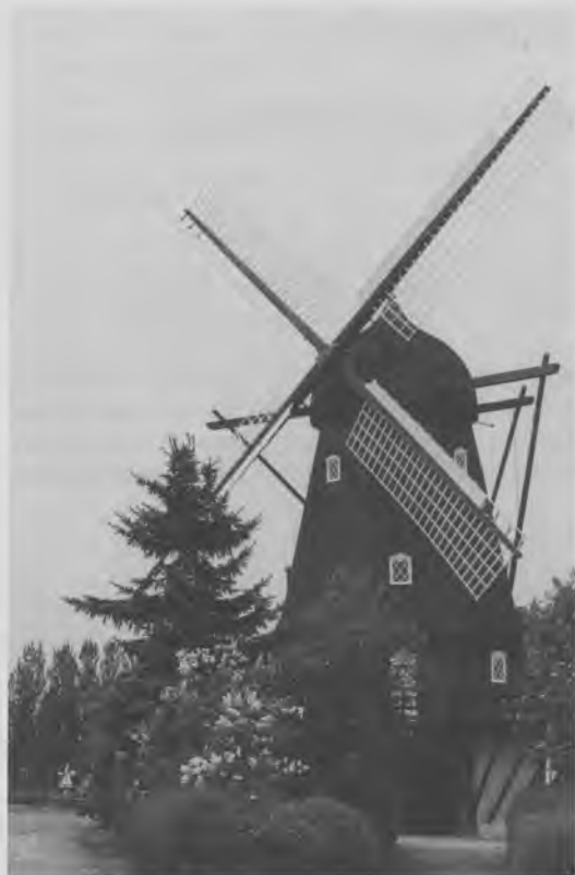
Fig. 1. Nr. Jernløse Mølle ved Holbæk. Et eksempel på en stor hollandsk mølle uden selvkrøger. Hatten drejes manuelt ved hjælp af den kraftige bjælkekonstruktion (svansen), som her ses ført ned til galleriet, hvor man med et spil manuelt kan trække i den og derved dreje hatten. Denne mølle udflyttedes ca. 1885 fra sin oprindelige placering på Helters Bastion (omtrent hvor Paladsteateret nu ligger) og genopførtes i Nr. Jernløse (Foto: Nils Erik Andersen).
