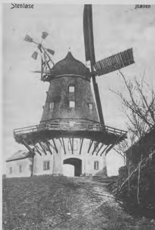
Fig. 2. Stenløse Mølle, efter alt at dømmes den tidligere Nybroe Mølle fra Vesterbro, ca. 1906, forbedret ca. 1900 med vindrose og selvkrøger. Opført på stedet omkring 1861-62, ca. 25 km fra sin første placering, på et nyt muret fundament (Foto: Stenløse Lokalarkiv).
