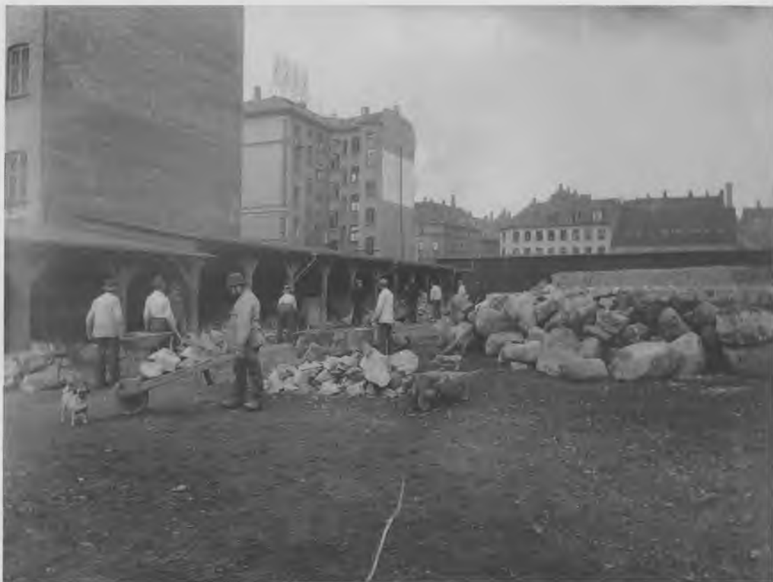
Fig. 7. Stenslagningsarbejdet var, at dømmе efter hvor mange der forlod det i utide, et af de mest forhadte arbejdsområder på Ladegaarden. Samtidig mente øvrigheden, at arbejdet var sundt og opbyggeligt og fremmende for en god arbejdsmoral. Fotografi ca. 1898 (Københavns Bymuseum).
