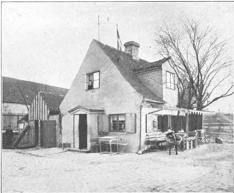
Bomhuset ved Langebro.
