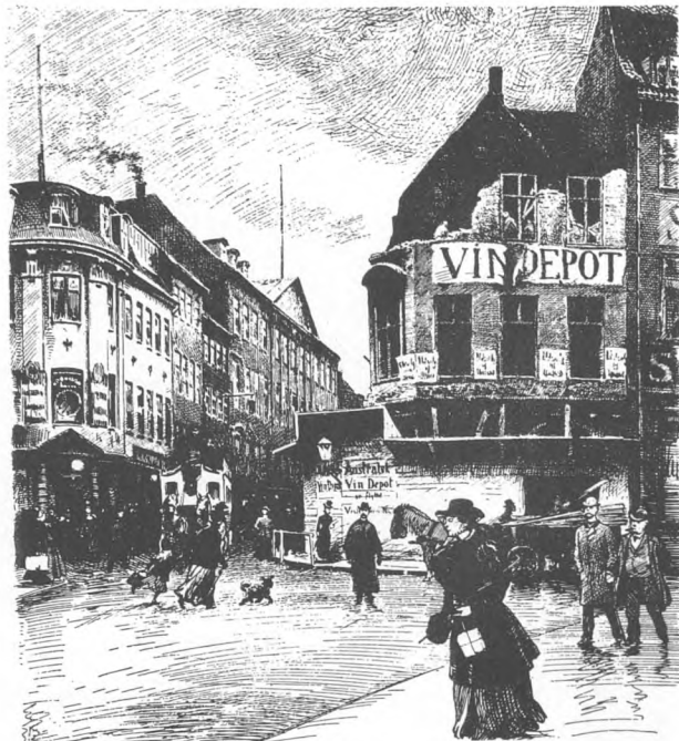
Nu skal Nygade udvides. Ovenfor ser man, at Hjørneejendommen ved Skoubogade allerede er ved at blive revet ned.
