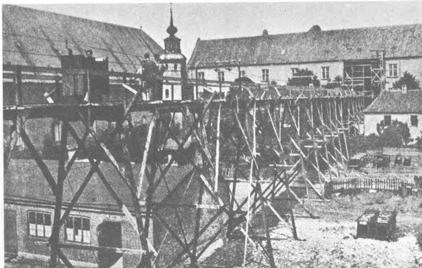
Forbindelsesbroen mellem den gamle og den ny Biblioteksbygning, hvor Bøgerne transporteres paa Tipvogne.
