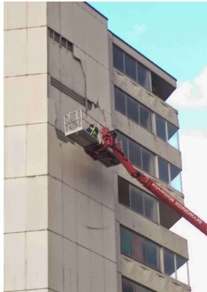
■ Fassadensicherung nach dem Sturm
