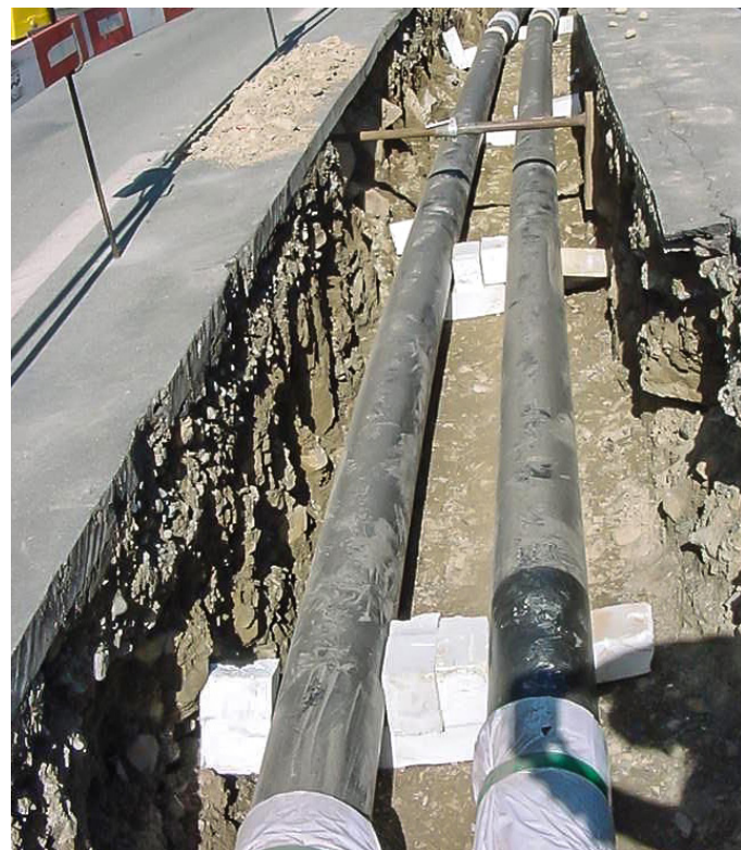
Beispiel einer Leitungsverlegung
