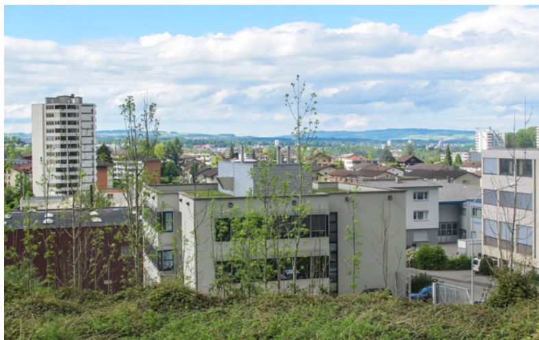
Standort der neuen Wärmezentrale neben dem Perosa-Gebäude.
