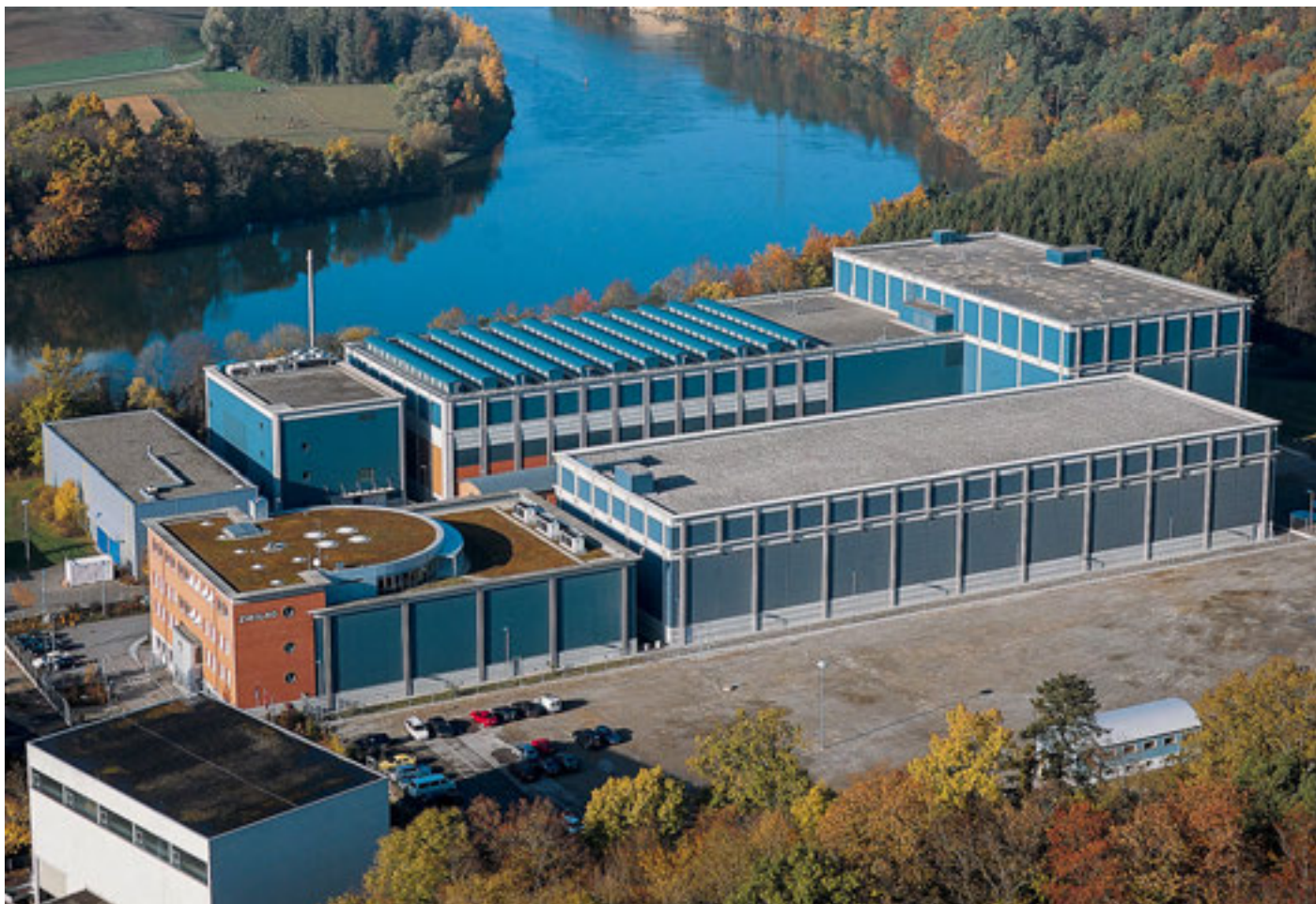
Hier lagert der radioaktive Abfall der Schweiz, bis ein Endlager gefunden ist: das Zwilag in Würenlingen (AG).
