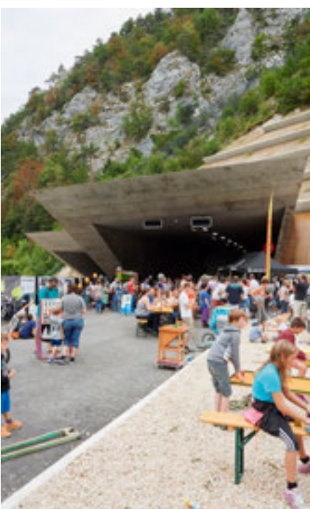
Das Südportal der A 16.
