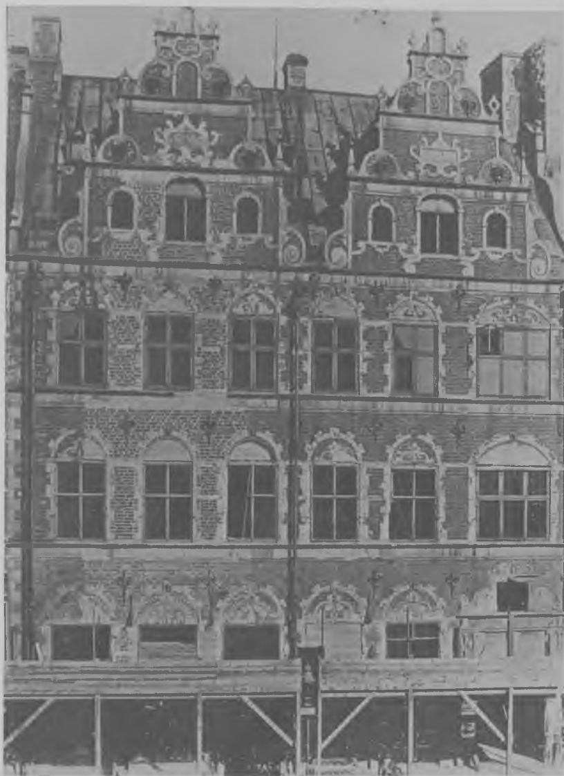
Amagertorv 6 opført 1616 for rådmand Mathias Hansen. På billedet, der er taget under restaureringen 1897-98, ses det, at murfladerne og de fleste sandstensdetaljer under en tidligere restaurering var blevet erstattet af imitationer udført i puds. Bortset fra butiksetagen synes gadesiden, som den står idag, at være en stort set korrekt genskabelse af den oprindelige facade. Københavns Bymuseum.
