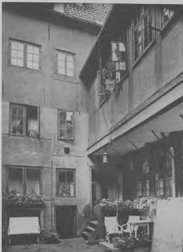
Strandgade 32. Forhusets gårdside med sidebygningens svalegang, der i ældre tid har været åben. Niels Elsving fot. 1948.
