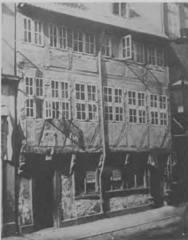
Pilestræde 21. Lejevåning af bindingsværk opført omkring år 1600 (senere forhøjet med en etage). Fotografi optaget kort før nedrivningen i 1874. Kunstakademiets Bibliotek.
