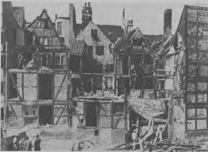
Lille Kongensgade 23-29 set bagfra under nedrivningen 1932. Bag de halvvejs nedrevne baghuse ser man tydeligt gavlhusenes gårdsider. Københavns Bymuseum.
