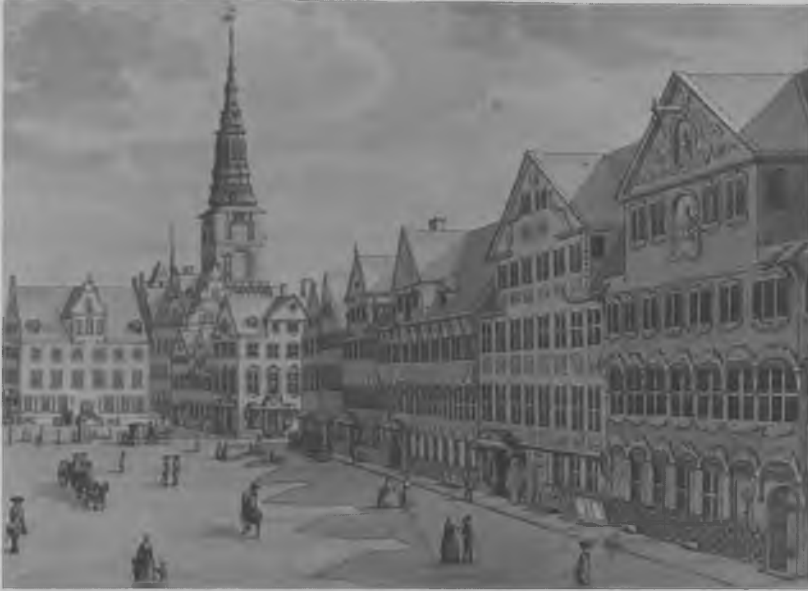
Amagertorv set mod øst. Udsnit af tegning udført af J. J. Bruun i 1756. Til højre ses flere af de tre stokværk høje bindingsværksbygninger fra tiden omkring 1600, som forsvandt under branden i 1795. Københavns Bymuseum.
