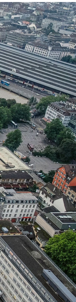
Das Gebiet beim Zusammenfluss von Sihl und Limmat ist heute dicht besiedelt. Der Hochwasserschutz musste angepasst werden.
