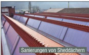
Shedverglasung mit Hagelschutzgitter
