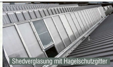
Sanierungen von Sheddächern
