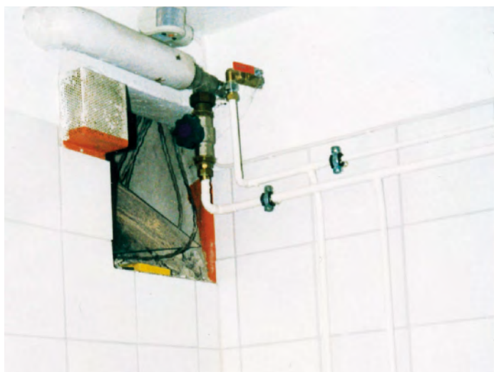
Sinkal-tablettene ble oppbevart i dette avlukket på guttetoiletet. Lukten sivet inn i luftventilen og direkte opp til formingssalen.
