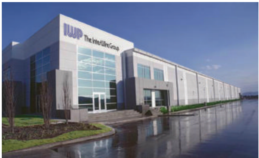
▲ Nouvelle installation de InterWire au Mexique
