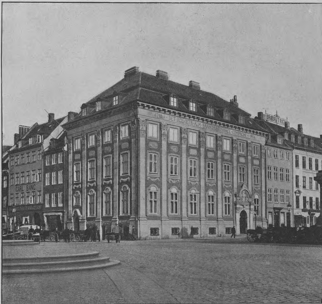
Ejendommen Nr. 10 Højbroplads ombygget i Aaret 1906 af Det kgl. oktroierede alm. Brandassurance-Kompagni, som har sine Lokaler i Bygningen.
