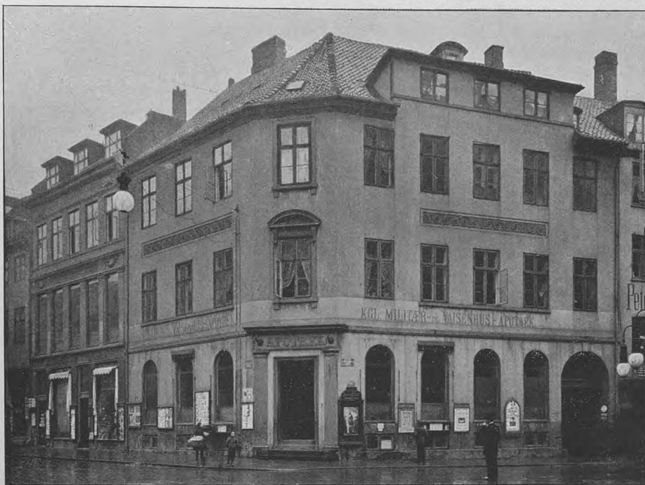
Det kgl. Militær- og Vaisenhus-Apothek (Hj. af Kronprinsensgade) forinden Ombygningen i Aaret 1902.
