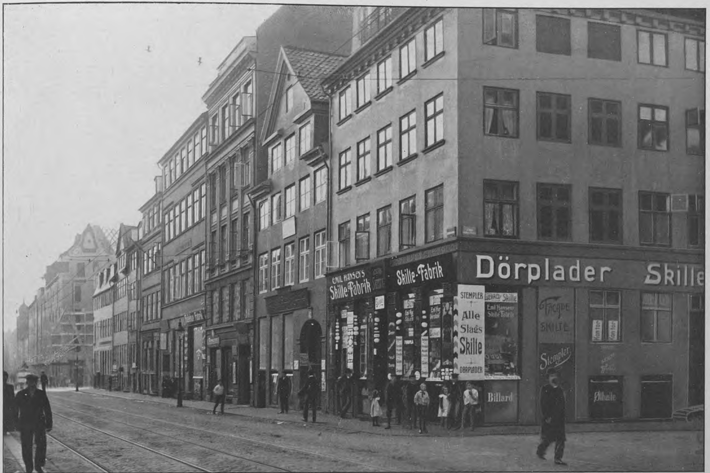
Fot. Raadhusforvalteren. Parti af den nedrevne Gothersgade imellem Store Brøndstræde og Møntergade i Aaret 1909. Møntergade.
