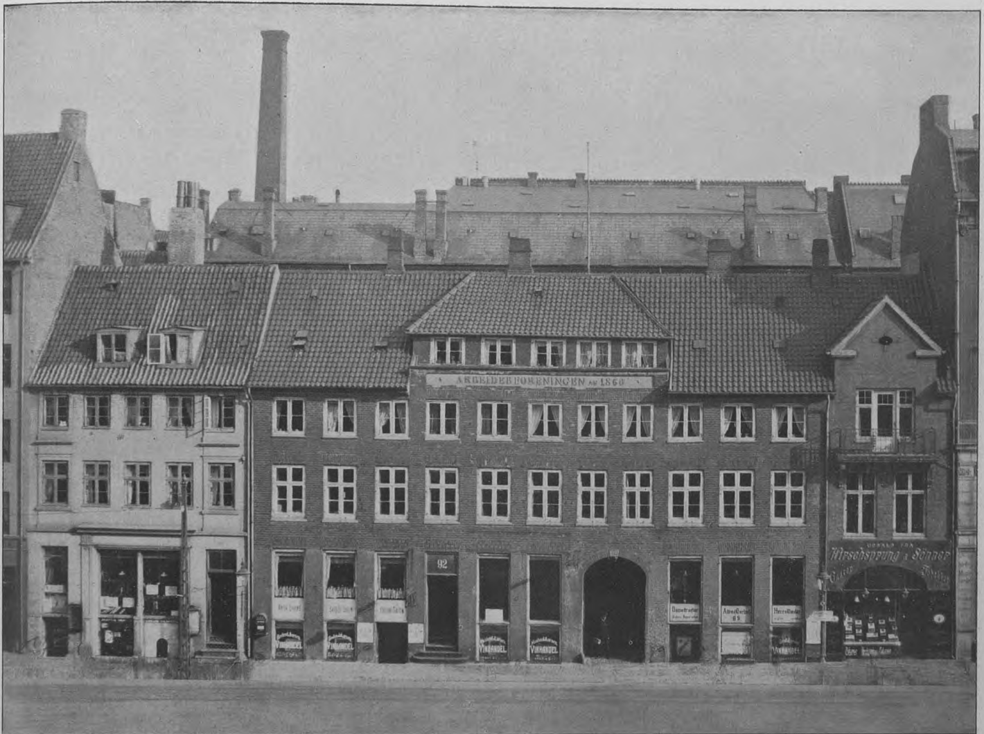
Arbejderforeningen af 1860s Bygning, Nørrevoldgade 90, forinden Ombygningen i Aaret 1915—16. (Se Teksten i næste Hefte).
