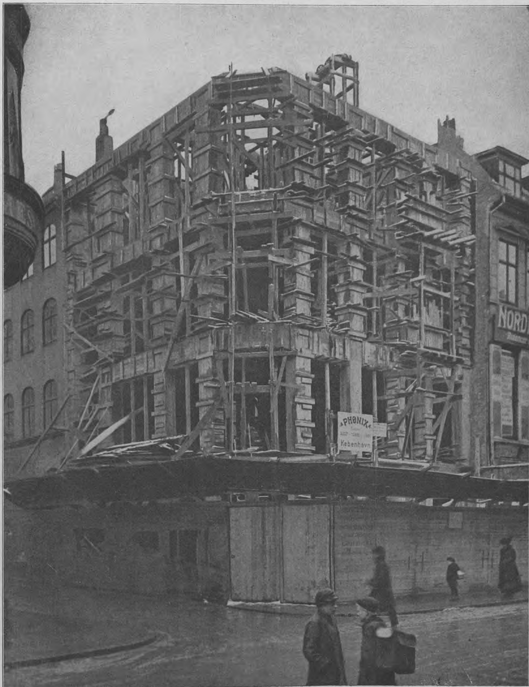
Den nye Ejendom, Købmagergade Nr. 40 (Hj. af Klareboderne) under Opførelse 1917 (Hennebique-Konstruktion) (Bygherren: Direktør Ernst Bojesen).
