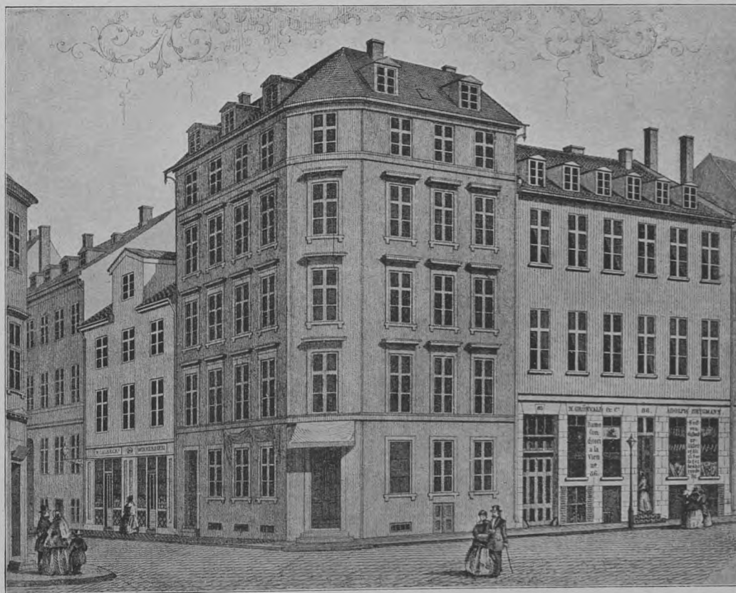
Ovenstaaende Ejendom, ombygget i 1860erne.
