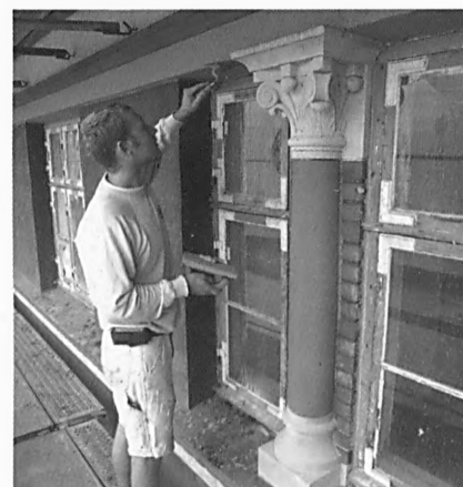
Mureren i arbejde
