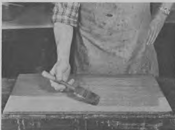
Fig. 606. Lakering af celluloselak med pensel bør være meget fyldig, og penslen bør holdes som vist på billedet.
