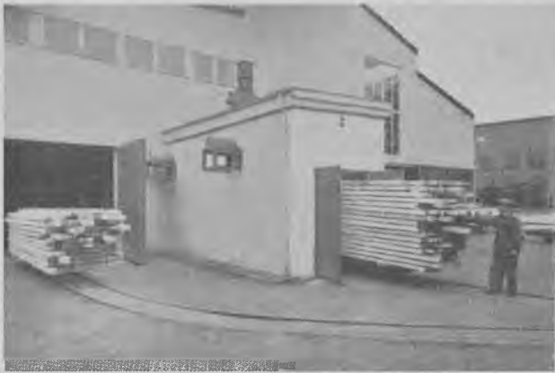
Fig. 78. Kammertørreanlæg med propelventilator. (Efter Svenska Flåktfabriken).
