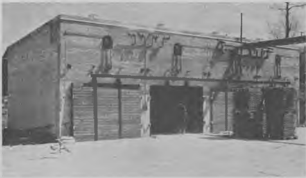
Fig. 79. Kammertørreanlæg med propelventilator og spjældregulering. (Efter Træindustriens Forskningsinstitut).
