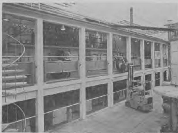
Fig. 605. Billede fra en moderne cellulosefabrik. Råvaren transporteres med trucks og bliver sammen med opløsningsmidlerne blandet i de i underetagen placerede blandemøller. Bemærk tårnet i højre side – det bruges til blanding af fortyndere.
