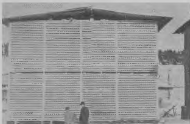
Fig. 66. Stabling af brædder til lufttørring.
