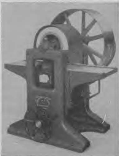
Fig. 211. Bokshøvl. En bokshøvls arbejdsmåde kan sammenlignes med en pudshøvls.
