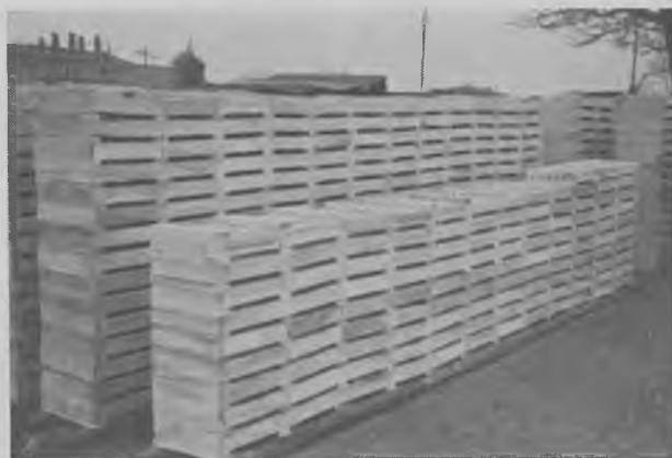
Fig. 64. Stabling af stav til lufttørring.
