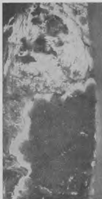
Fig. 19. Hussvamp ( Merulius lacrymans ) udviklet på undersiden af et gulvbræt.
