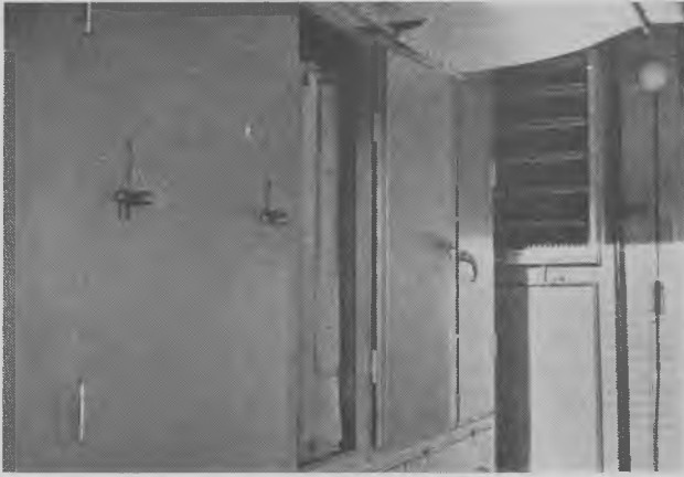
Fig. 330. Vakuumfilter til et støvsugningsanlæg til pudsemaskiner. Under filterposerne er anbragt et antal kasser til opsamling af støvet. Bemærk varmepladen i baggrunden, hvorigennem den rensede luft går tilbage til arbejdslokalet.
