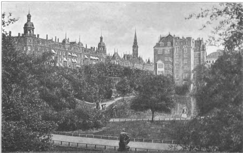
En Udsigt, vi mister. (Aborreparken, hvor Gravemaskinerne har begyndt deres Arbejde, der om kort Tid vil udslutte dette smukke Bybillede.)
