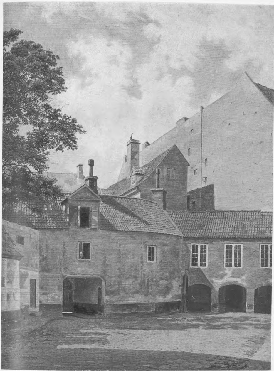
Det Thottske Palæ set fra palæets baggård i 1840 og er næsten uforandret til i dag. Beskueren står i baggården ved det sorte x, der er anført i kortet fra 1807 og ser mod syd. Øverst til venstre ses tagryggen af palæets hovedbygning langs med Kongens Nytorv. Måske var det i »Runden«, der ses i forgrunden, at H. C. Ørsted holdt forelæsninger 1813-1819. Den franske ambassade ejer palæet. Oliemaleriet af J. Vermehren er på lærred, 25×45 cm. 1840.
