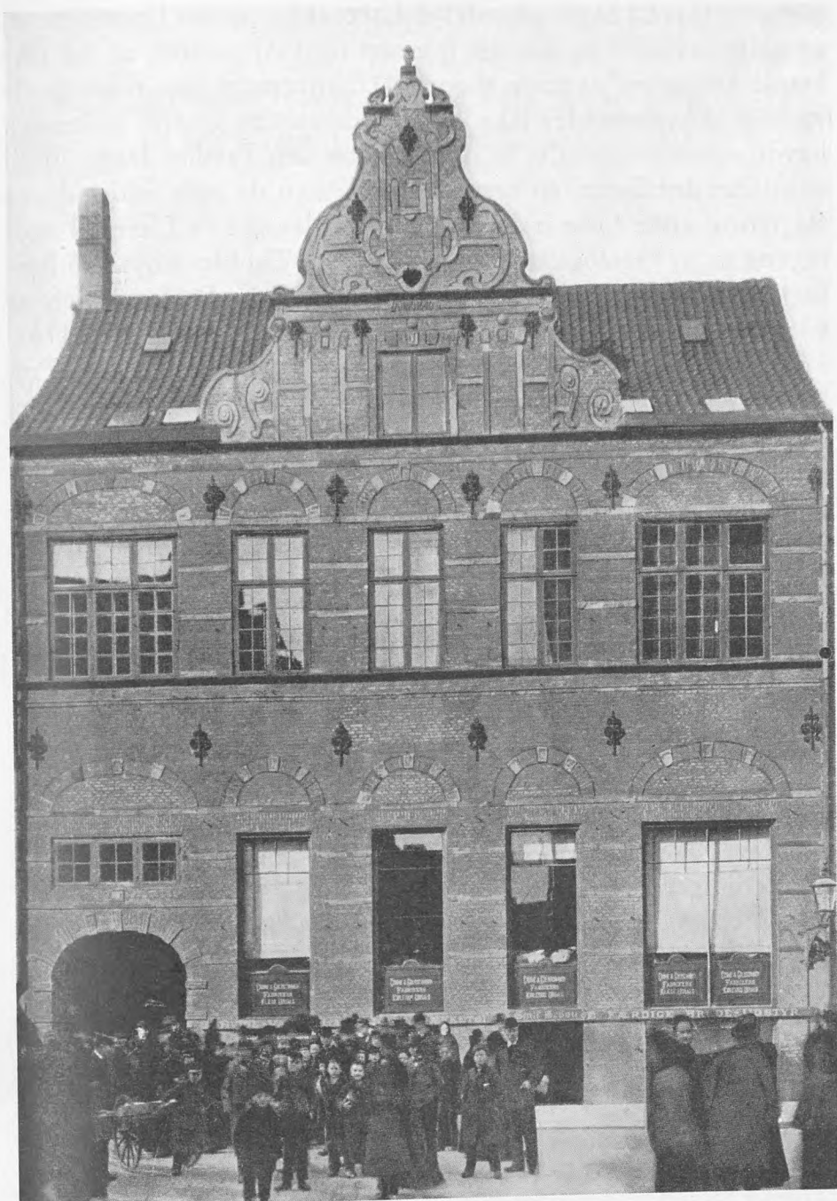
Forhuset til »Müllers Gaard«, Østergade 52, umiddelbart inden nedrivning i 1911. Gården blev bygget 1640. Nu ligger hovedindgangen til Illums varehus her.
