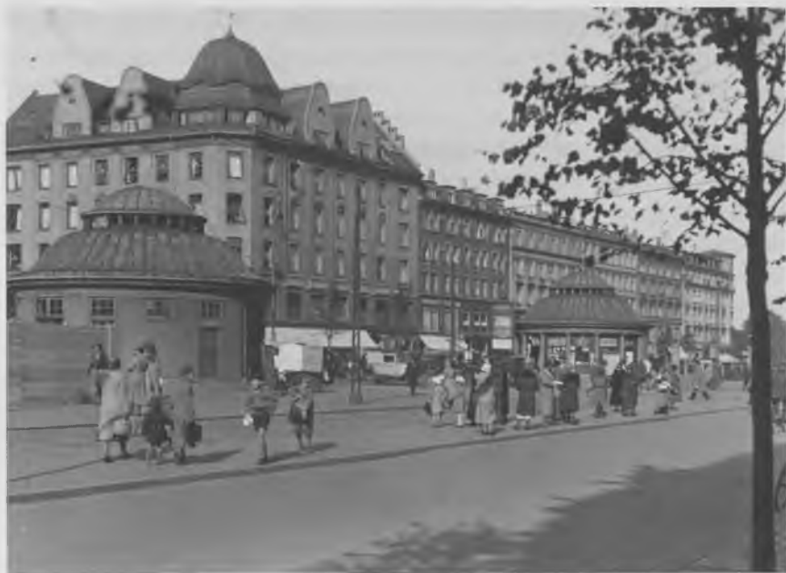
Nørreport station i begyndelsen af 1930'erne. De to pavilloner byggedes til ventilation af den underjordiske station, billet salg og ventesal. Pavillonerne, der kaldtes suppeterrinerne, blev nedrevet kort efter at dette billede blev taget. Perronnedgangen yderst til højre i billedet bruges stadig. Foto på Bymuseet.
