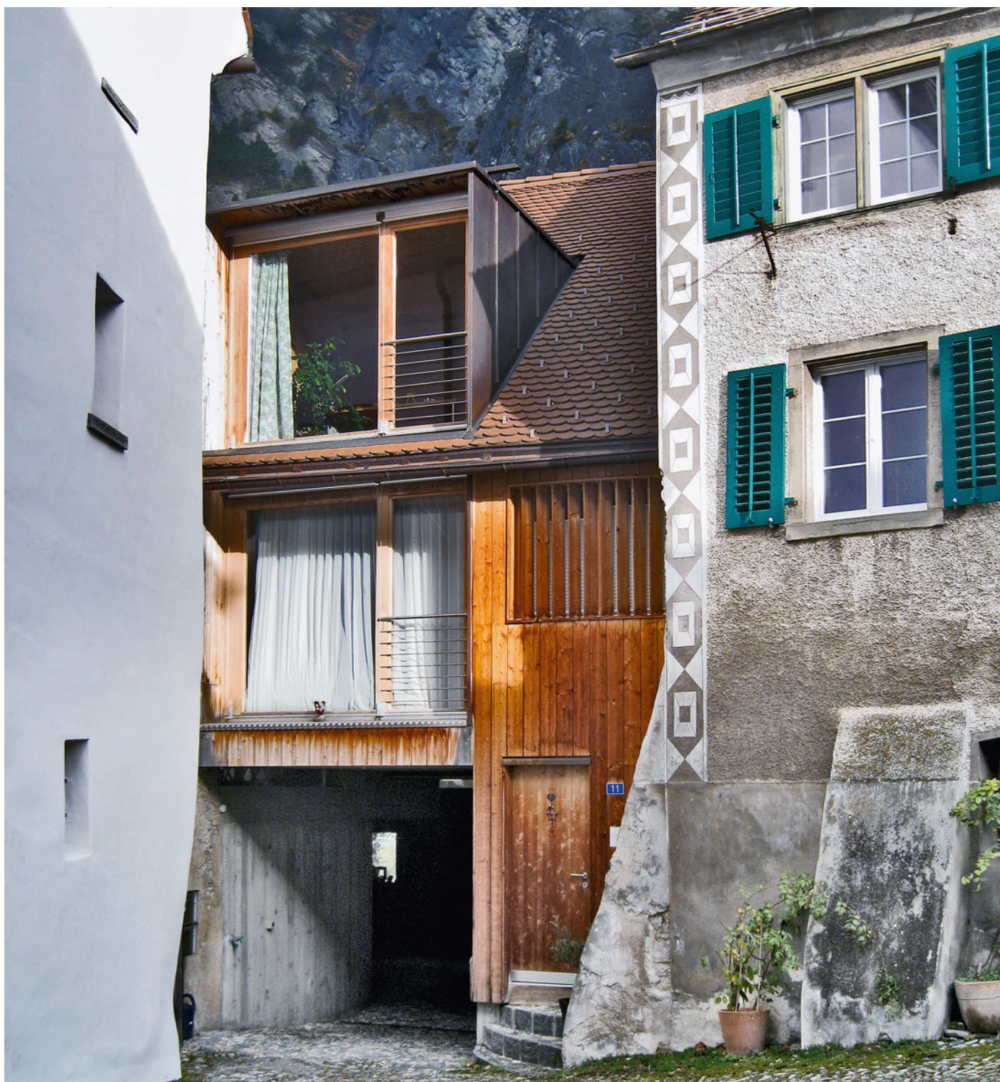
Erhalten, Umnutzen und Verdichten im Dorf: ein Beispiel aus Fläsch (GR).
