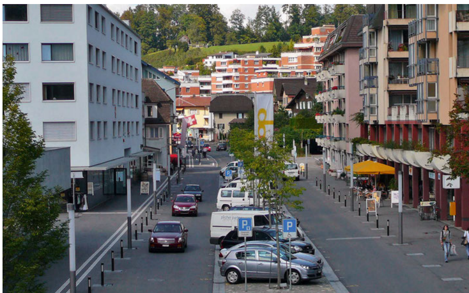
Die neu gestaltete Kantonsstrasse in Horw.
