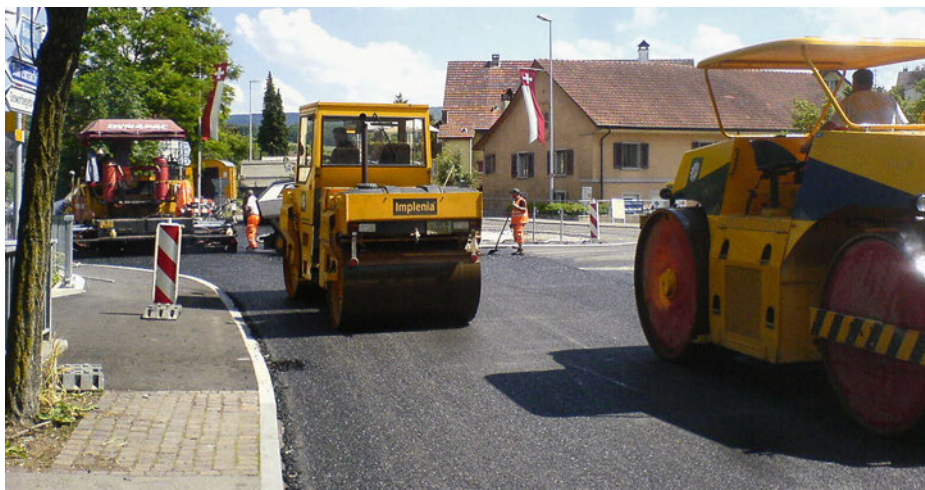
Einbau eines Strassenbelags.
