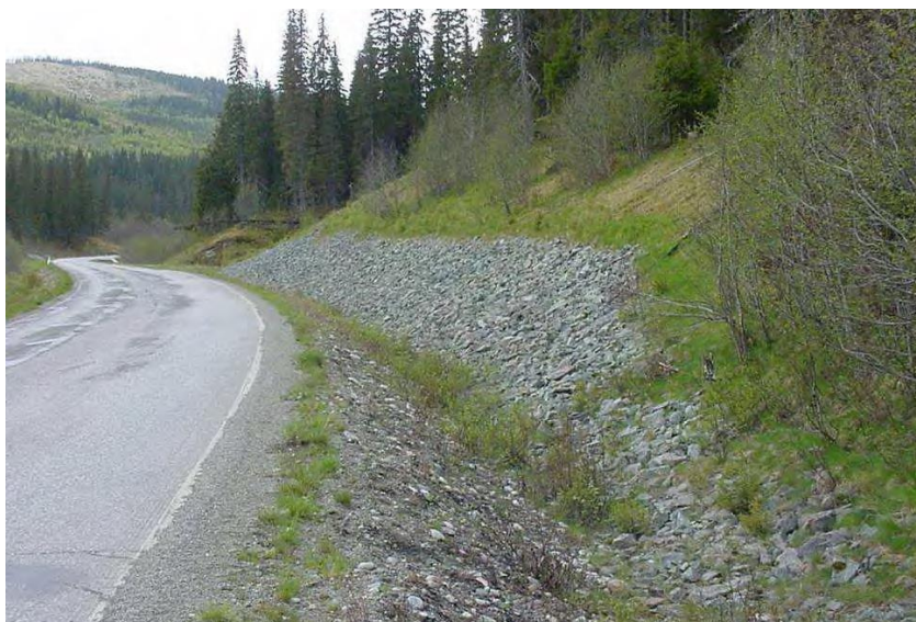
Figur 245.6 Masseutskifting i skråningsfot (Gartland i Nord-Trøndelag. Foto: Kjell Eriksen)
