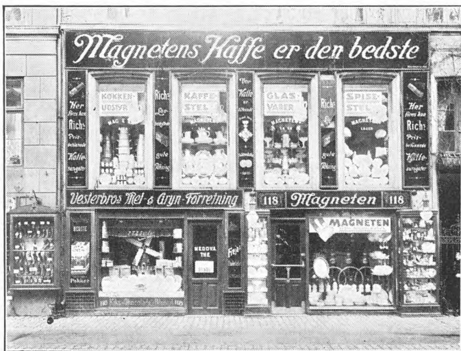
Firmaet Magnetens Forretning paa Vesterbrogade.
