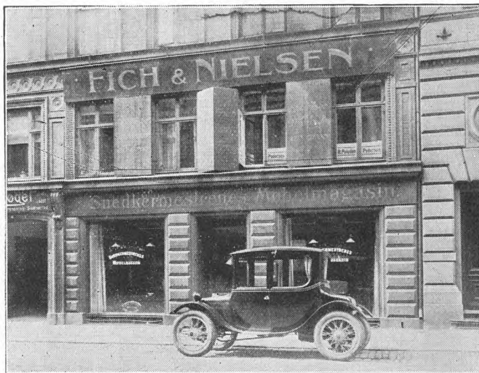
Ejendommen hvori Firmaet Fich & Nielsen har sine Lokaler.
