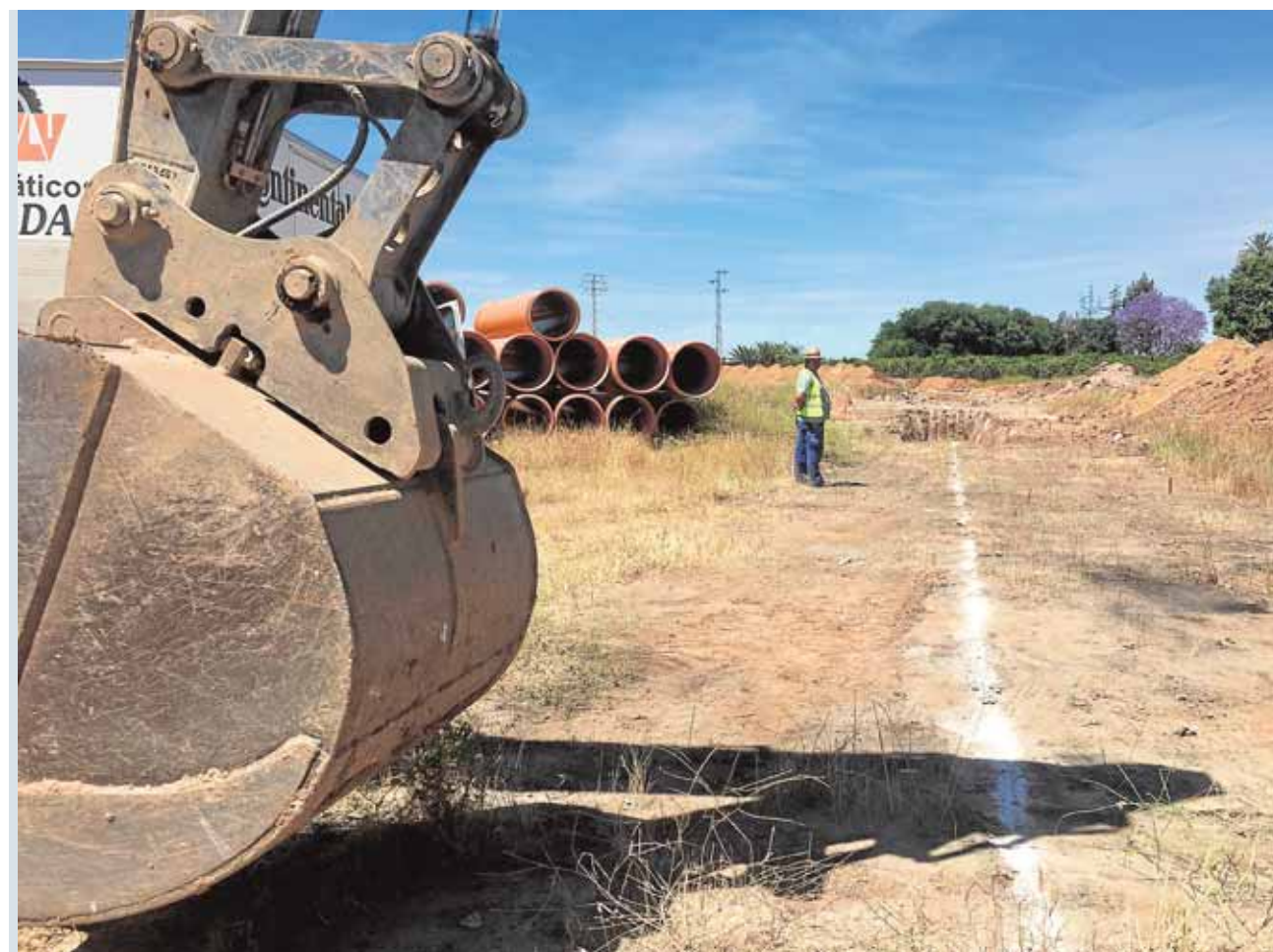
Imagen del inicio de las obras para la construcción del aliviadero en la localidad de Los Rosales
