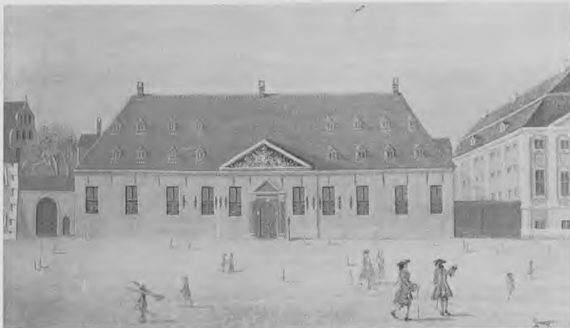
Fig. 5. Gjethuset på Kongens Nytorv malet af Rach og Eegberg ca. 1750. Bygningen lå der, hvor det Kgl. Teater i dag ligger. Bag den strenge facade støbtes rytterstatuen i 1768. Ellers var der blevet støbt både klokker og kanoner i huset (Nationalmuseet).
