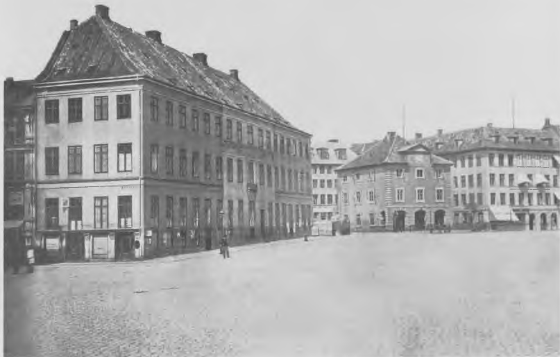
Fig.10. Det gamle hotel d'Angleterre og Hovedvagten på Kongens Nytorv. Bag hotellet lå en større have, der grænsede op til bagsiden af husene i Peder Madsens Gang. Hotellet og Hovedvagten blev nedrevet i forbindelse med opførelsen af Ny Østergade og Hovedvagtsgade (Før og nu 1917, s. 208).
