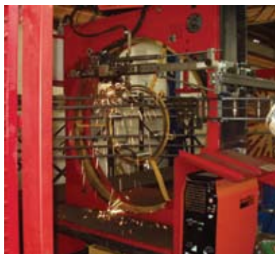
▲ Soldadura con la nueva ensambladora GAM
