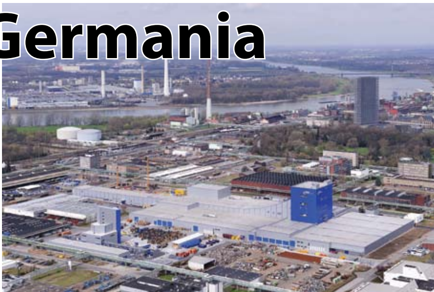
▲ Nuovo stabilimento per la produzione di cavi di nkt in Germania
