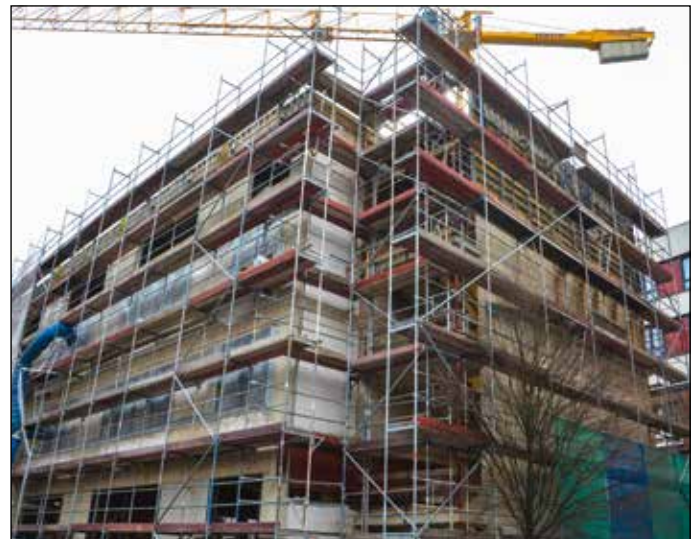
Der Bau geht zügig voran
