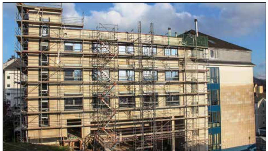
Die Bauarbeiten verlaufen nach Plan
