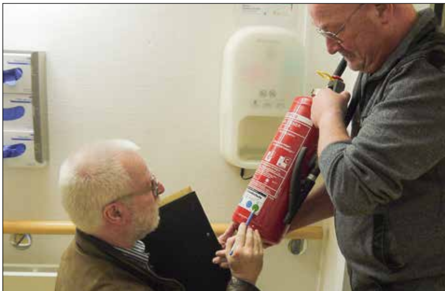
Christoph Weber, Technischer Leiter, und Ulrich Boll, Hygienefachkraft, überprüfen auf dem Rundgang einen Feuerlöscher
