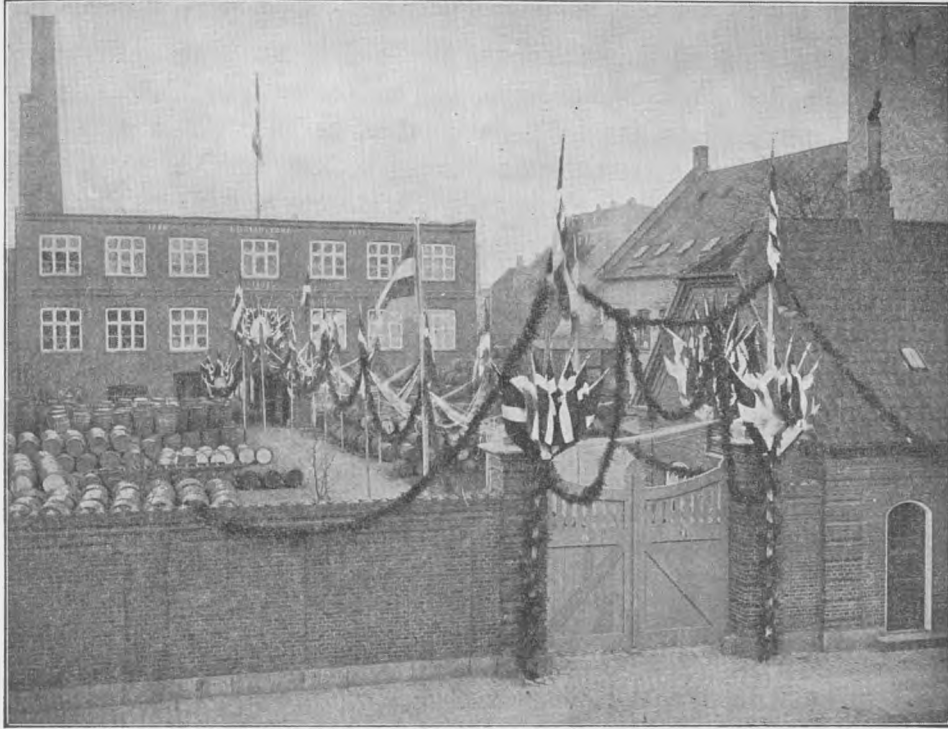
Hovedbygningen af 1891, flagsmykket til Jubilæet 30. December 1905.
