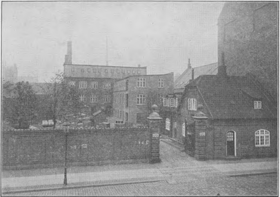
L. C. Glad & Co.s Fabrik med den nye Løbetilbygning 1923.
