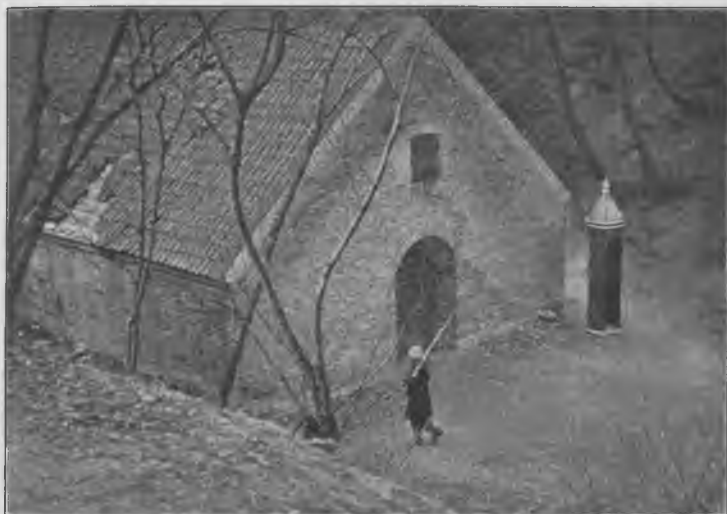
1. Krudttaarnet i Dronningens Bastion. Fot.
