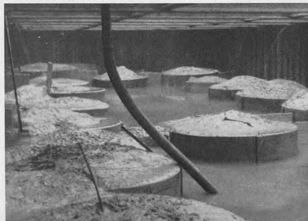
Nederst i byggegrube. Undervandsbetonen kommer til syne ved læns-pumpningen. Fotografi fra december 1950.
