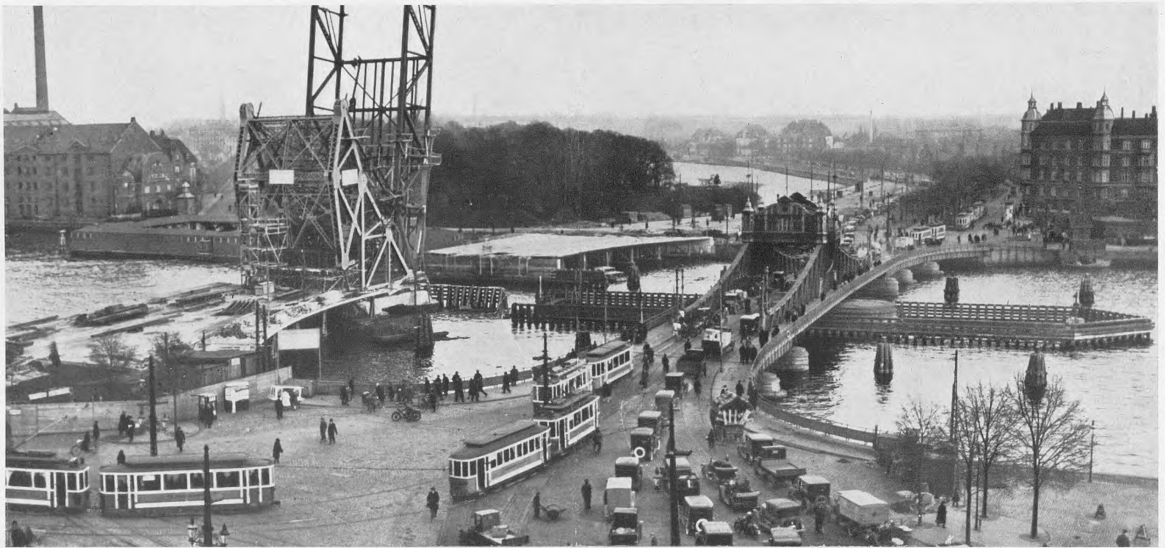
Interimsbroen under udførelse. Til højre svingbroen fra 1903. Fotografi 1930.
