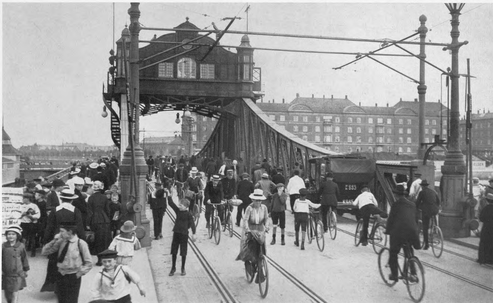
Langebro 1916. Fotografi taget under 1. verdenskrig. Allerede ved anlæggelsen af broen var cyklisttrafikken et problem, man mente at måtte tage i betragtning. Cyklisternes antal blev mangedoblet i den »menneskealder« svingbroen var i brug, og den oplevede tillige at se de cyklende damers fodsides klædebon vige for de knækorte kjoler.
