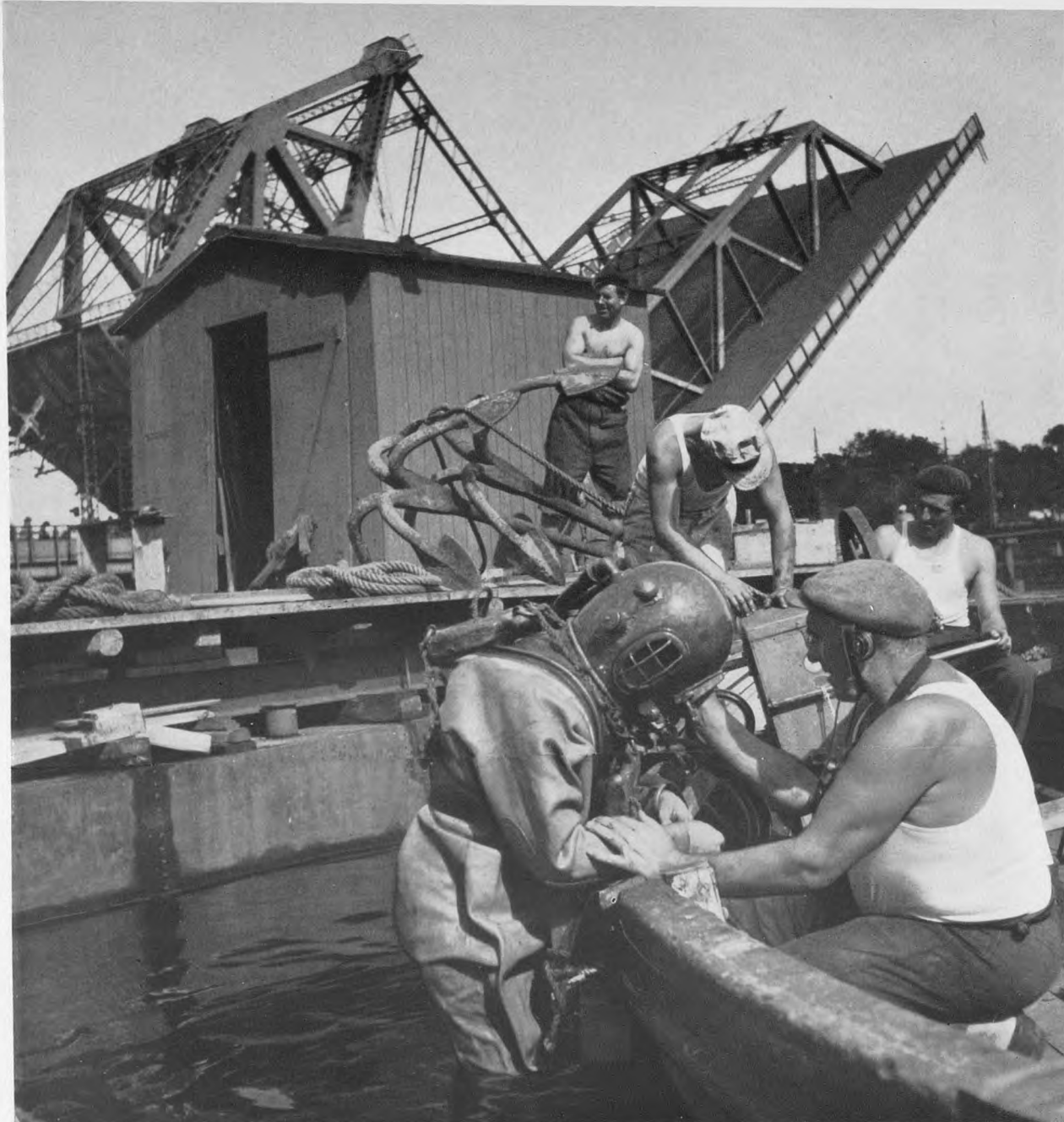
Dykker i arbejde under påbegyndelsen af den nye bro. Selvom bundforholdene var bekendt fra tidligere undersøgelser, har dykkere under opførelsen af den nye Langebro ved flere lejligheder været i virksomhed, blandt andet inden nedramningen af pæle og spunsjern. Billedet herover er taget i juli 1949, da broarbejdet endnu var helt i sin vorden.
