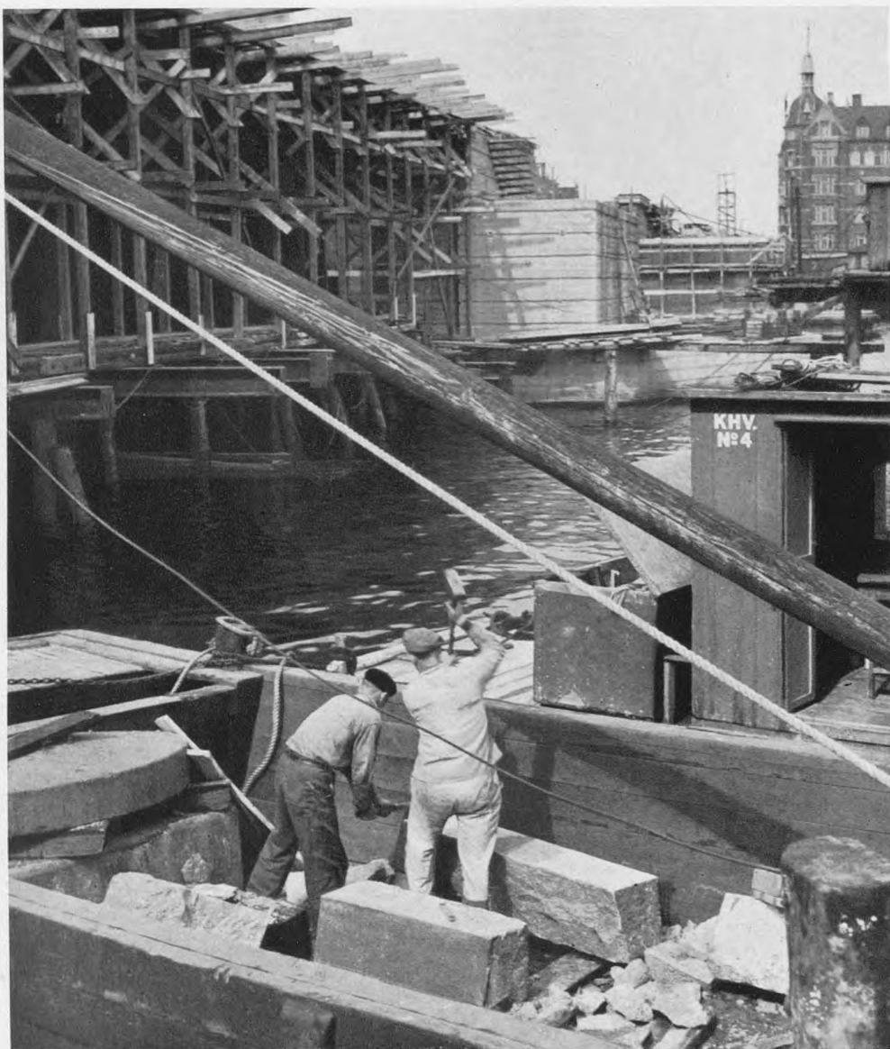
Der tildannes granit til bropillernes beklædning. Fotografi fra april 1953. Foruden de mange vognfulde beton medgår der tillige anseelige mængder af natursten til den nye bro. Hertil kommer andre materialer som stål og tømmer, det sidste almindeligt kun anvendt mere interimistisk, til stilladser o. lign. Man ser til venstre i billedet en del af stilladset til Sjællandssidens jernbetonbuefag. Se også billedet næste side.
