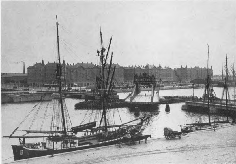
Svingbroen under åbning. Fotografi o.1910 i havnevesenets arkiv.
