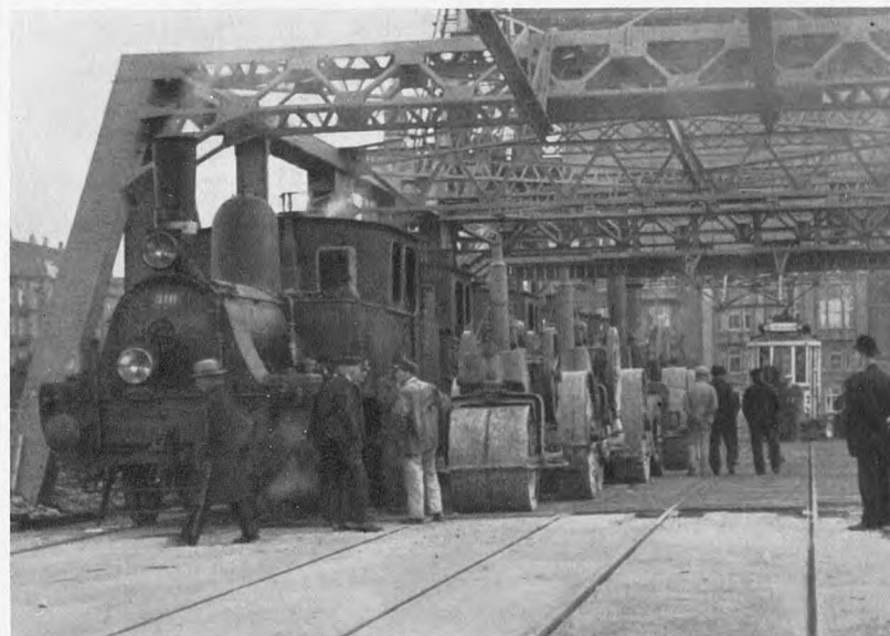
Belastningsprøve af Interimsbroen. Fotografi 1930.
