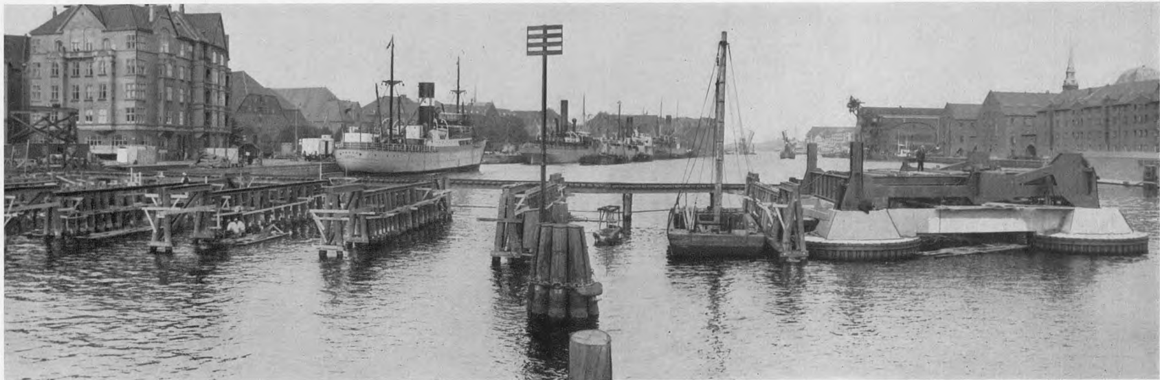
Interimsbroen under udførelse. På underbygningens nedrammede fyrretræspæle ses dele af klappagets stålkonstruktion.
