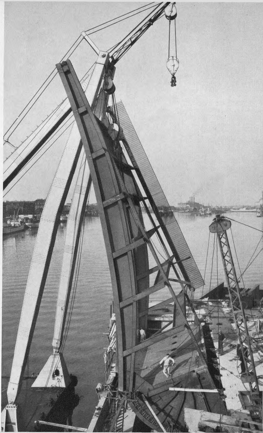
Begge broer er oppe. Fotografi fra 1953. I forgrunden Sjællandsklappens stålkonstruktion. I baggrunden interimsbroen.
