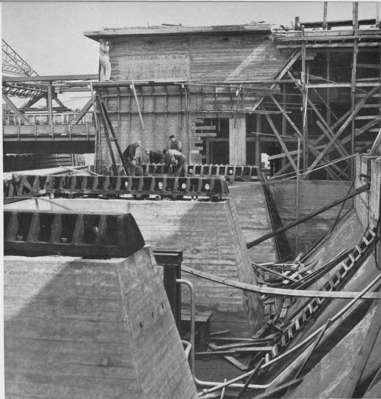
Der arbejdes med bromaskineriet i østlige klappille. Linjerne i det afbildede bygningsværk på dette fotografi fra 1953 bringer en til at tænke på et ægyptisk tempel, men billedet forestiller slet og ret en del af det store hulrum i østre klappille, hvor de rullebaner er under montering, som skal muliggøre bevægelsen af den ene af Langebros klapper.
