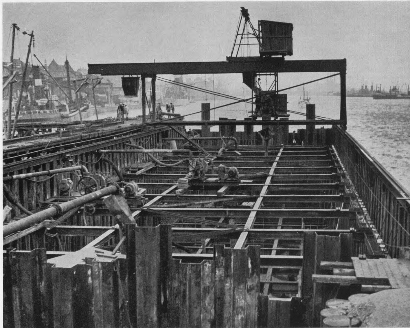
Østlige klappille efter læsningen. Fotografi fra februar 1952. Som ved støbningen af den vestlige klappille blev der også her benyttet en kørekran, som løb ad skinner lagt oven på de to lange spunsvægge. I nederste højre hjørne af billedet skimtes – udenfor spunsvæggen – den duc d'Albe, som var anbragt ind imod sejløbet for at beskytte byggegruben mod påsejlinger.
