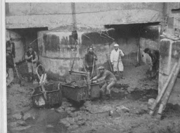
Der arbejdes i tørlagt byggegrube 12 m under havets overflade. Fotografi fra 1950.
