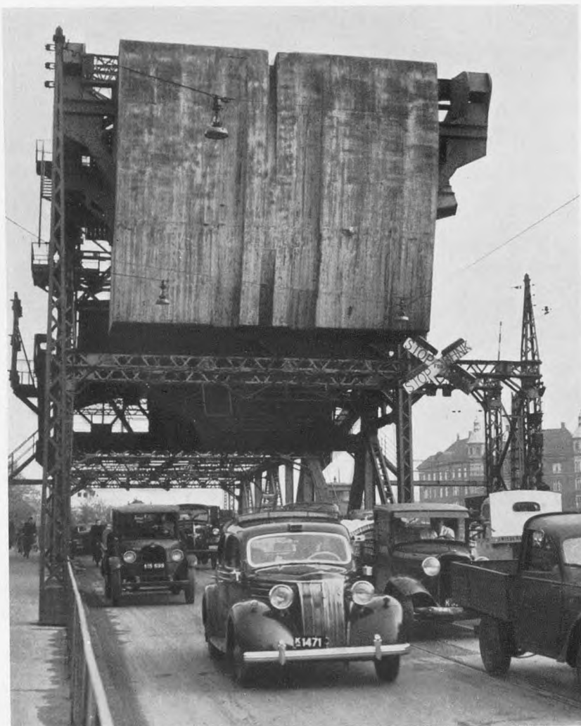
Biltrafik på interimsbroen. Fotografi fra 1952. Kontravægten, ophængt over kørebanen, har en vægt af 960 tons.
