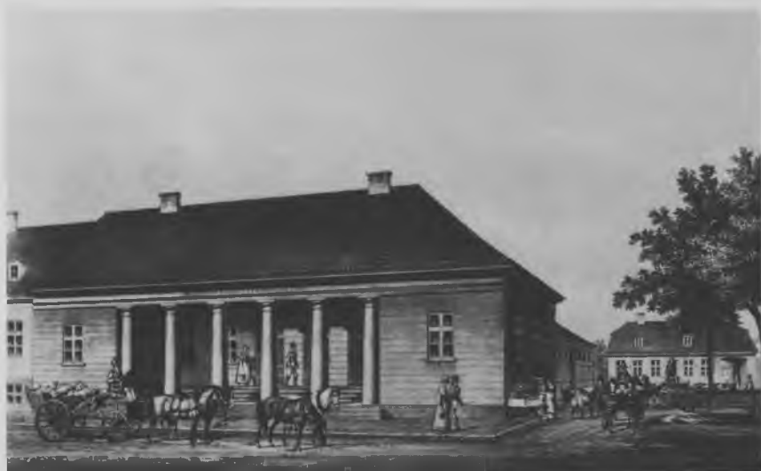
Acciseboden på Vesterbro ved hjørnet af Vesterbrogade og Trommesalen. Bygningen opførtes 1811 efter tegning af C.B. Hornbech og fungerede som accisebod til 1851. Den blev i ombygget tilstand revet ned i 1883. Tegning af H.G.F. Holm ca. 1830. Københavns Bymuseum.
