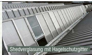
Sanierungen von Sheddächern
