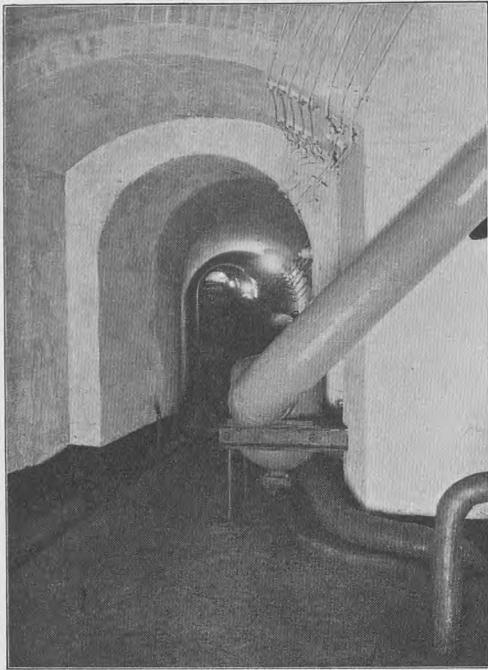
FIG. VI. BETONTUNNEL FRA KJEDELHUSET TIL RAADHUSET
