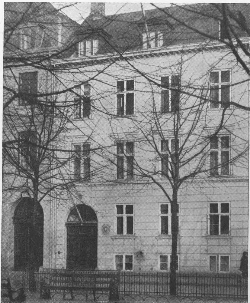
Sct. Annæ Plads 7. Facaden 1928 før Ombygningen.
