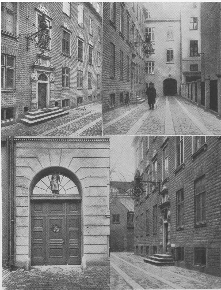
Sct. Annæ Plads 7. Porten samt Gaarden efter Ombygningen 1929.
