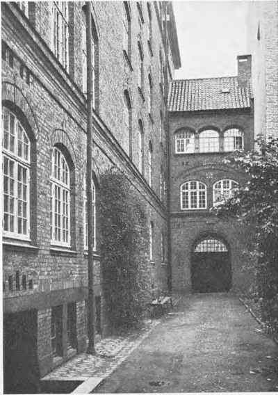
Østre Sidefløj, med østre Pavillon.
