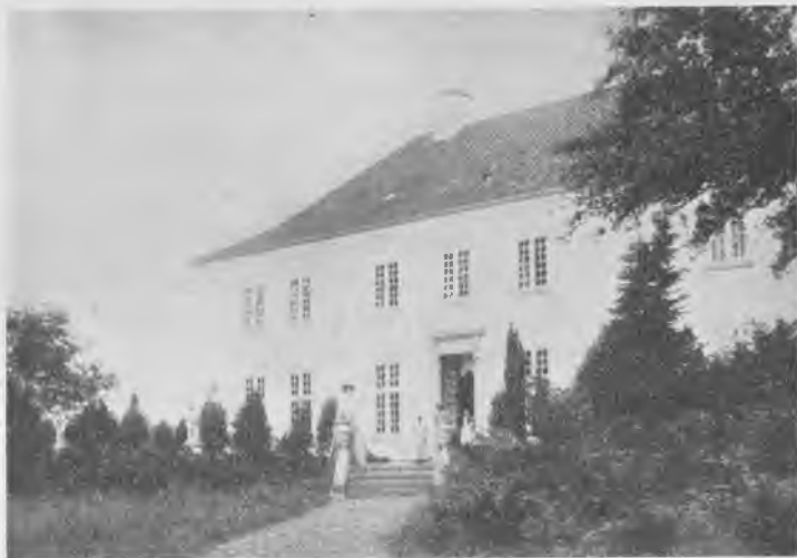
Aldershvile hovedbygning, havesiden 1899.
