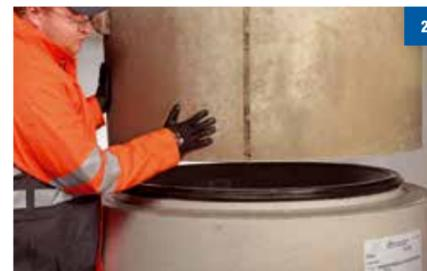
2 Positionner l'élément supérieur en s'assurant qu'il soit bien horizontal et centré par rapport à l'élément inférieur.
