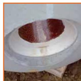
Directement intégré lors de la fabrication, le manchon d'étanchéité adapté à la canalisation grès garantit une parfaite étanchéité avec continuité de Fe. Ces manchons d'étanchéité sont propres au matériau de branchement.
