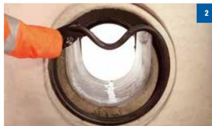
2 Poser le joint en appui sur la face extérieure béton tout en formant un « cœur » en sa partie supérieure.
