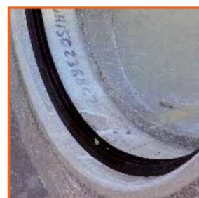
Le manchon PRV est une solution d'étanchéité intégrée lors du coulage du fond hydraulique monobloc pour garantir une étanchéité aux raccordements selon le DN de la canalisation et son angle.
