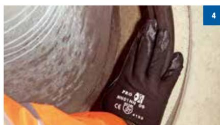
4 Une fois le joint monté, s'assurer qu'il est en butée sur la paroi béton en tapant avec la paume de la main sur toute sa circonférence.
