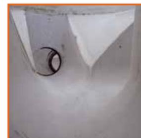
Pour éviter le risque de stagnation des eaux sur les banquettes, Stradal propose la réalisation d'une banquette en pente sur-mesure pour favoriser l'écoulement des eaux et éviter les risques d'émanation d'H<sub>2</sub>S. Lors d'entrées en chute, les banquettes en pente accompagnent les effluents dans la cunette.
