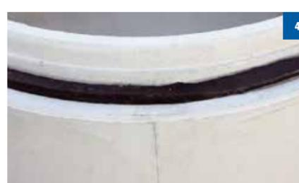
4 Raccorder le joint bout à bout en liant par modelage et sans chevauchement les deux extrémités.
