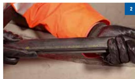
2 Préparer le joint en veillant à ce que les inscriptions soient sur la face extérieure et à l'envers. **Ne jamais graisser le joint ni l'emboîtement femelle.**
