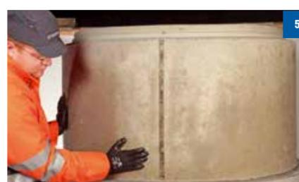
5 Descendre verticalement l'élément supérieur en le centrant à l'aide du trait de repérage des échelons par rapport à l'élément inférieur et ce, jusqu'au contact avec le joint plastomère. A l'aide d'une pièce de bois, exercer une pression verticale uniforme pendant 1 min au moins sur l'élément supérieur pour assurer l'étanchéité de l'assemblage.
