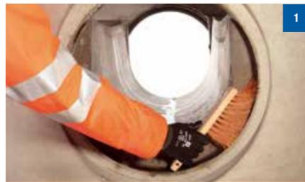
1 Avant la pose du joint de branchement, nettoyer la réservation béton à l'aide d'une brosse.
