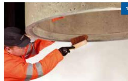
1 Utiliser les outils de manutention appropriés sur l'élément à mettre en place puis broser avec soin le profil de l'emboîtement.
