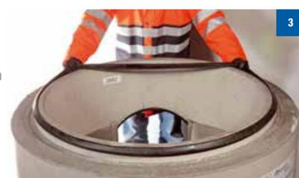
3 Poser le joint sur sa portée béton comme indiqué sur la photo. Mettre le joint en place sur l'épaulement supérieur de l'emboîture mâle.
