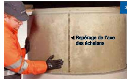
3 Descendre l'élément jusqu'au contact du joint en l'ayant au préalable aligné avec les échelons grâce au trait de repérage de l'axe central des échelons. Centrer et guider l'élément jusqu'au contact béton extérieur.
