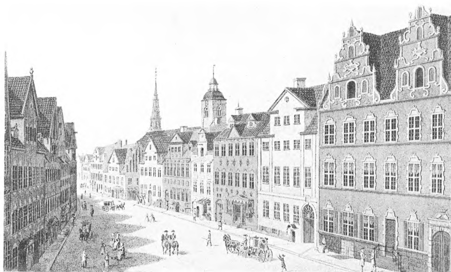
57. Prospekt fra Amagertorv med Ejendommen Nr. 6 længst til højre. Litografi efter en Akvarel fra 1755.
