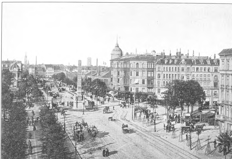
14. Udsigt over Vesterbros Passage mod Halmtorvet i Slutningen af 70'erne. Fot.
