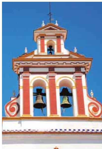
La espadaña y las puertas laterales se erigen entre los años 1789 y 1792
