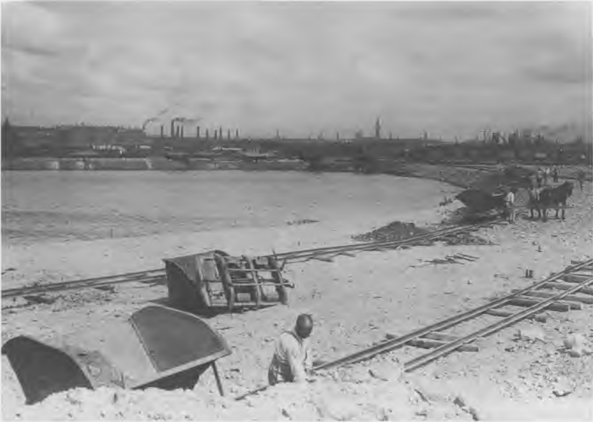
Kalvebod Strand, hvor opfyldningen nærmer sig Teglholmen og Teglværkshavnen. Tipvogne tømmer grus ud i vådområdet. Foto 1913 Københavns Bymuseum.
