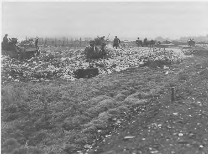
Hestetrukne skraldevogne tømmes på Valby Fælded efter Bradfords metode. Foto 1932 Københavns Bymuseum.
