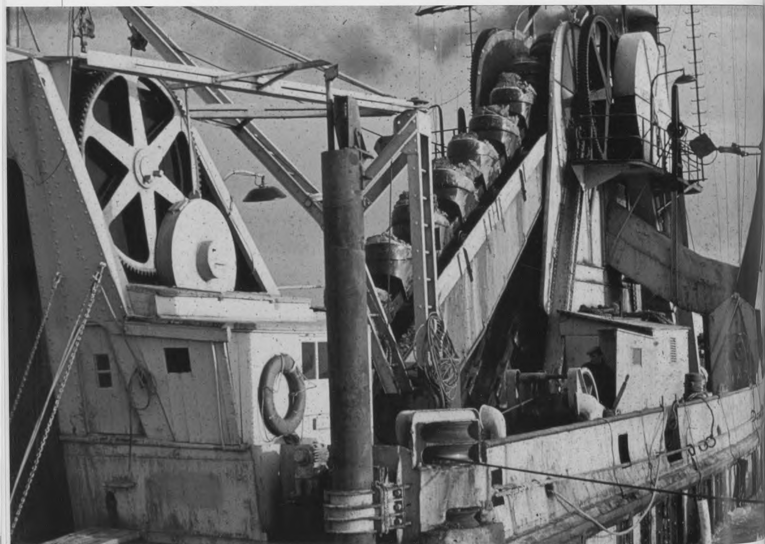
Gravemaskine til udgravning under vand. Anvendt ved anlæg af udløbsledningen fra Renseanlæg Lynetten, 1975.
