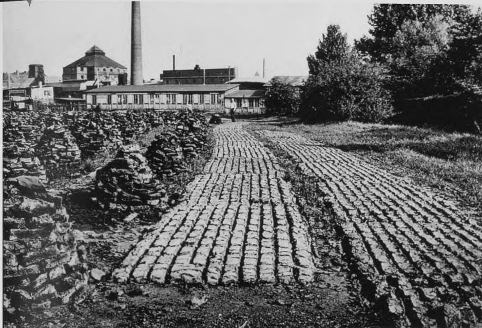
Slamkager lagt ud til tørring. Efter tørring kunne de stables og var lettere at transportere.
