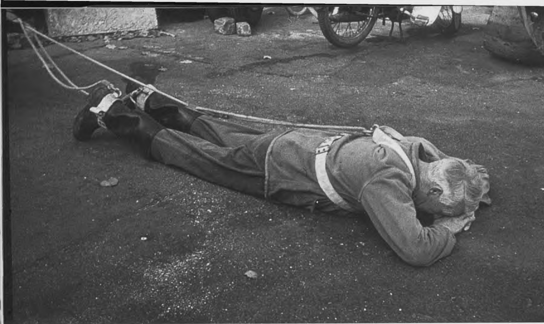
Ved inspektion af mindre ledninger iføres kloakarbejderen remme, så han med reb kan trækkes ud af kloakken. Omkring 1960.
