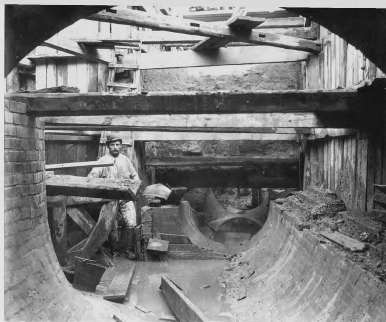
Bygværk på muret ledning under udførelse. Omkring 1900.
