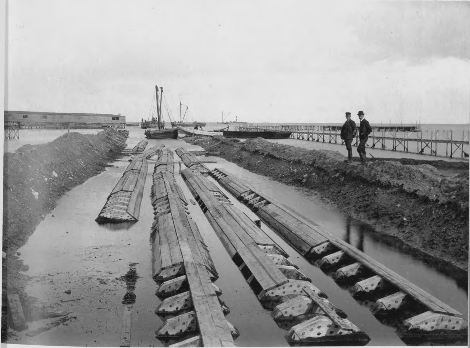
Udløbsledning af træ under konstruktion i Svaneværkbugten. 1906.
