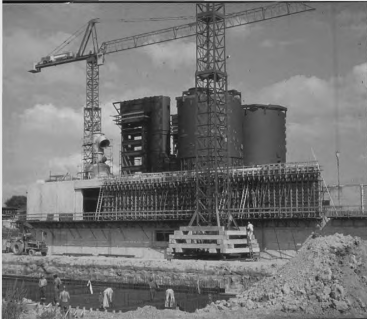
Bygning af Renseanlæg Lynetten. 1975.
