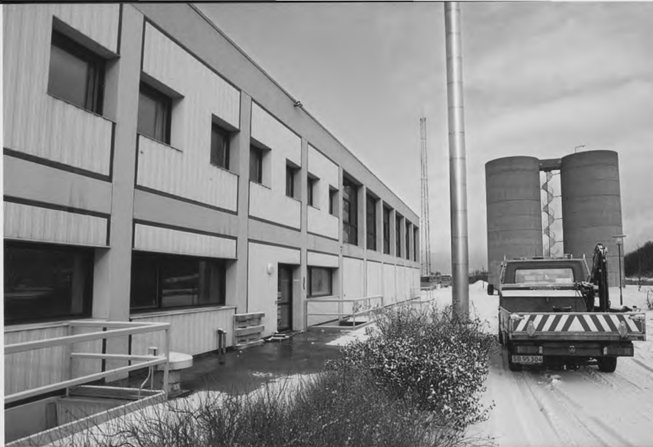
Sjællandsbrosen pumpestation. En moderne pumpestation fra 1970.
