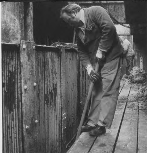
Ingerslevsgade pumpestation. Ristene renses manuelt. I løbet af 1970'erne kom der nye pumpetyper, som ikke så let stoppede til, og mange riste kunne derefter undværes. Billedet er formentlig fra omkring 1960.
