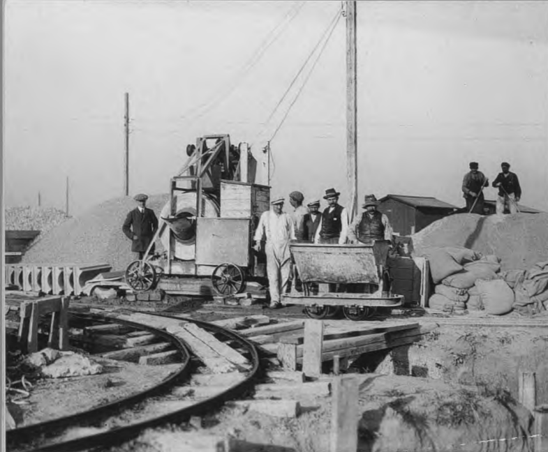
Man producerede selv sine egne betonrør på særlige pladser. De store rør blev dog enten støbt på stedet eller samlet af støbte elementer. Omkring 1920.
