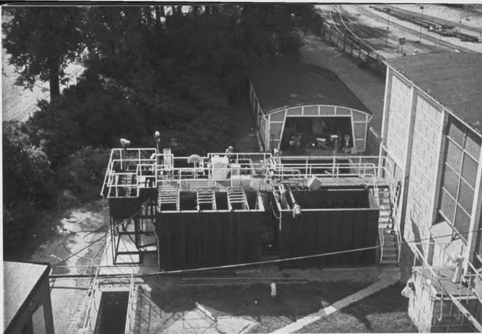
Forsøgsanlæg til rensning med ren ilt. Opstillet på Strandvængets pumpestation. 1973.
