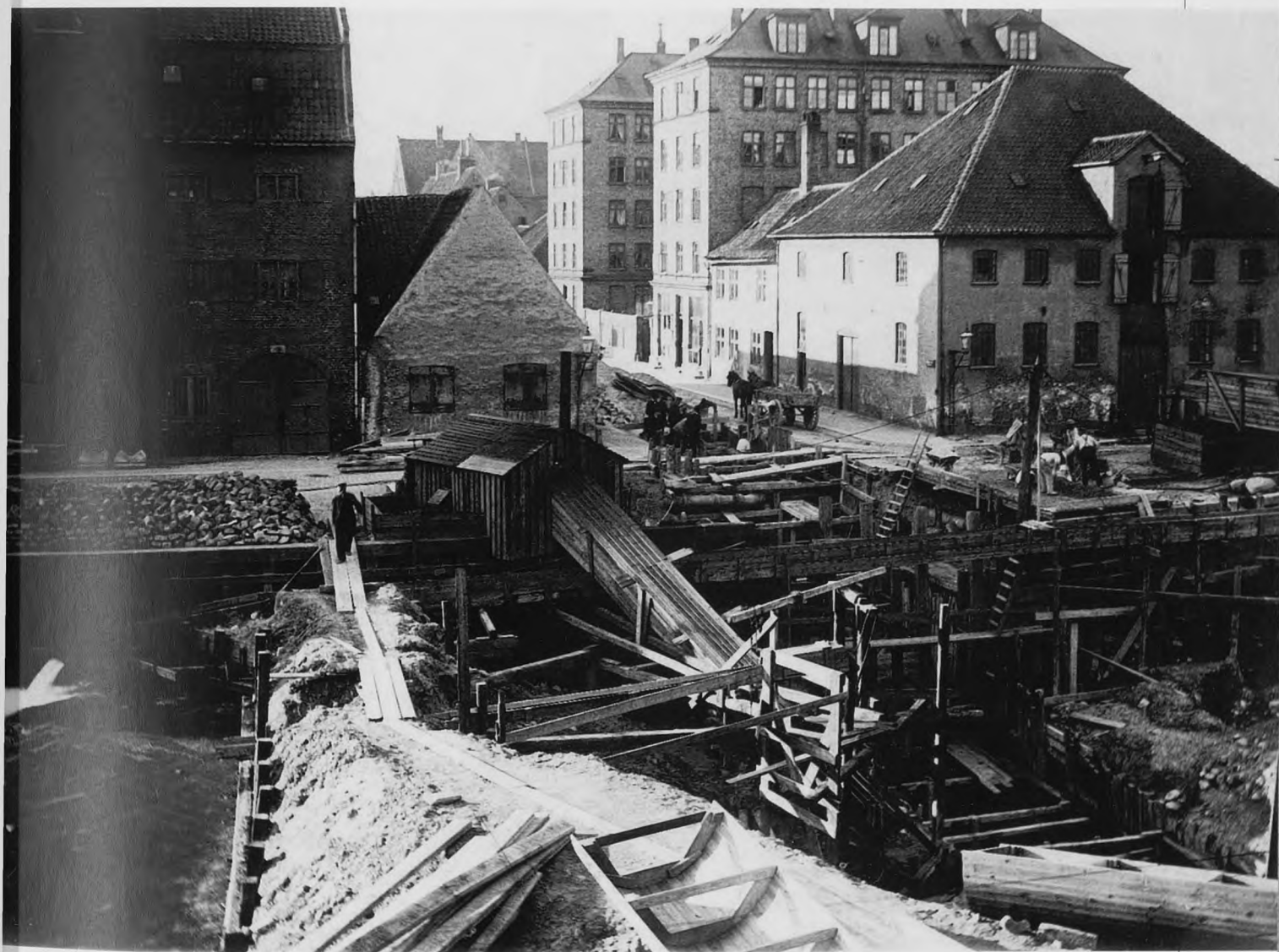
Dykkeren under Christianshavns kanal under udførelse ved Bådsmadsstræde. 1900.
