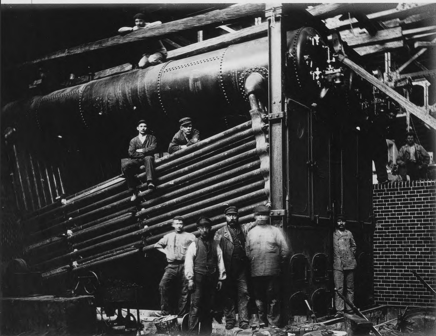
Dampkedlen på Kløvermarksvej Pumpestation.
