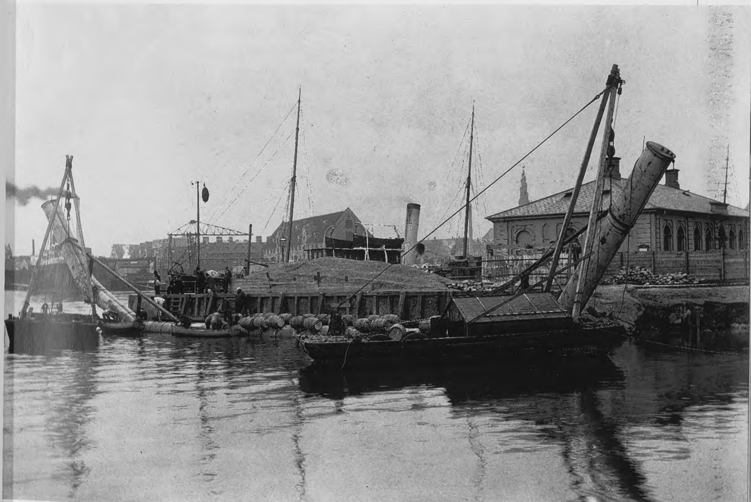
Dykkerrør til dykkeren under Nyhavn er klar til at blive sænket ned på bunden af kanalen. Omkring 1900.
