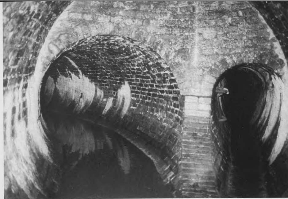
De store kloakker blev især i perioden fra 1860-1890 bygget op af mursten. Et materiale som har vist sin holdbarhed, idet de murede kloakker stadig indgår i kloaksystemet stort set uden vedligeholdelse.
