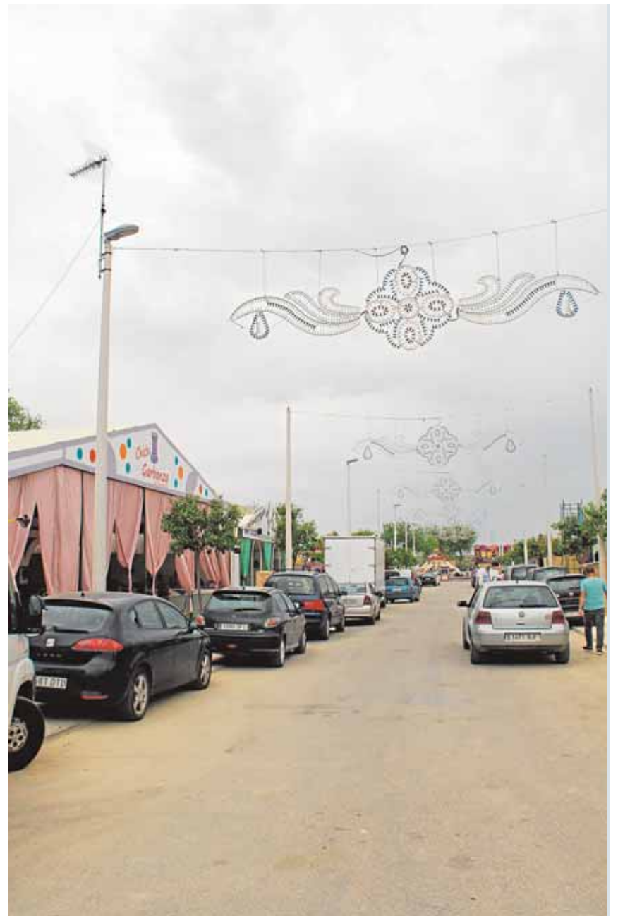
Montaje de las casetas de la Feria de Mayo de Paradas
