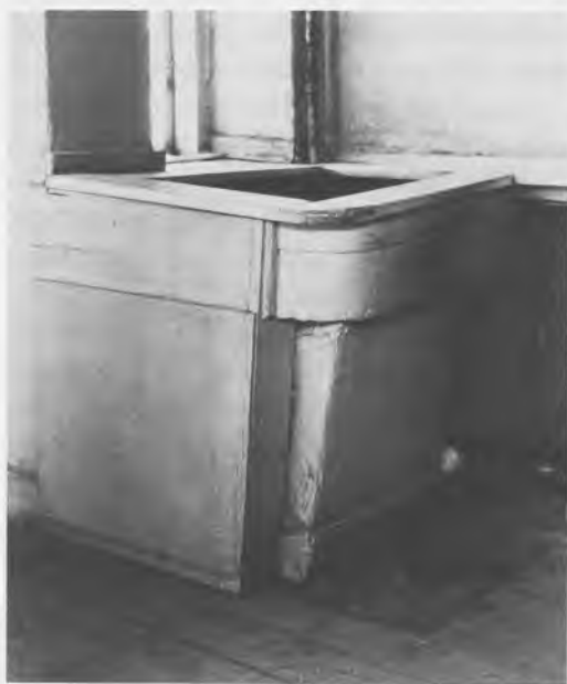
Stenvask med senere træbeklædning i Dronningens Tværgade 52. Kbh. stadsarkiv fot. 1954.
