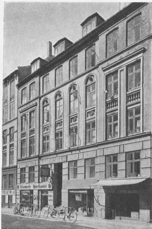
Usædvanlig trappeanbringelse for større lejligheder. Trapperne fungerer begge som hovedtrappe for een lejlighed i hver etage og kun i brandtilfælde benyttes forbindelsen mellem dem.
