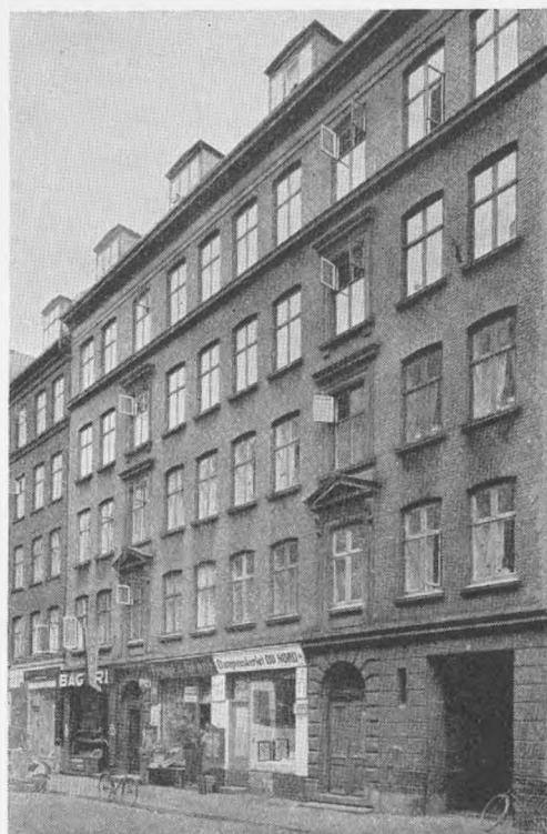
I Forhuset har man ved at skyde køkkentrappen ud i garden faaet plads til en alkove. Husene er ivoirigt ganske ens
