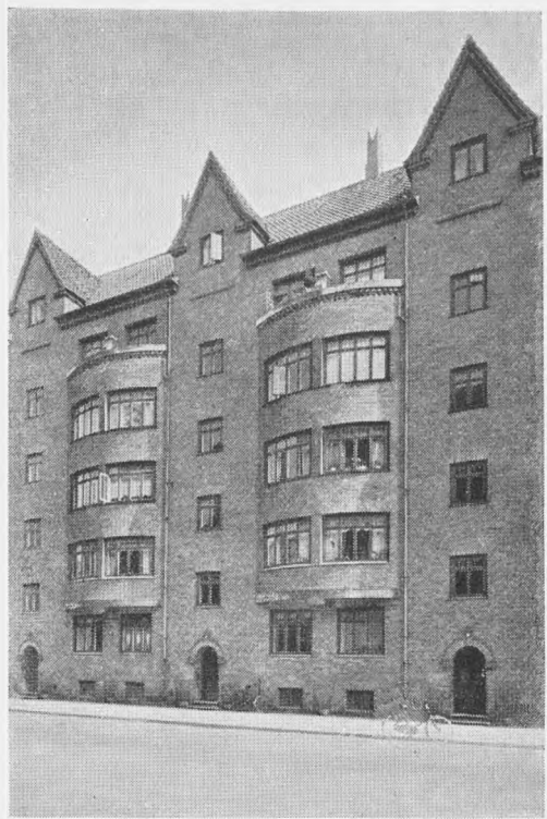
Den brede karnap indeholder vinduer til to lejligheds opholdsrum
