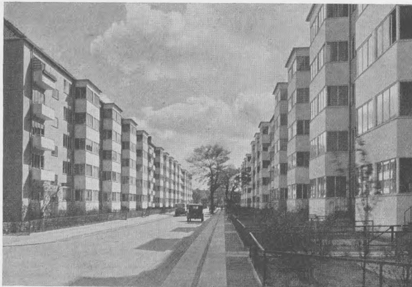
Vestervænget ved Enghavevej. Opført 1935 af Københavns almindelige Boligselskab. Stokkebebyggelse med eentrappesystem og altaner til to sider. Altanerne mod gaden er udformet med sammenklappelige vinduer, saaledes at de kan benyttes som solverandaer. Arkitekt: P. Søegaard Pedersen
