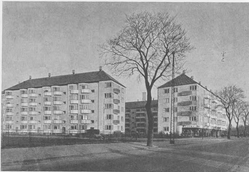
Roskildegården ved Roskildevej. Opført 1934 af Københavns almindelige Boligselskab. Halvlukket karré i 5 etager med eentrappesystem, med altaner med lukket brystværn i forbindelse med sydvendte karnapper. Arkitekt: Henning Jørgensen. Bebyggelsesplan B k , platype IV 39g
